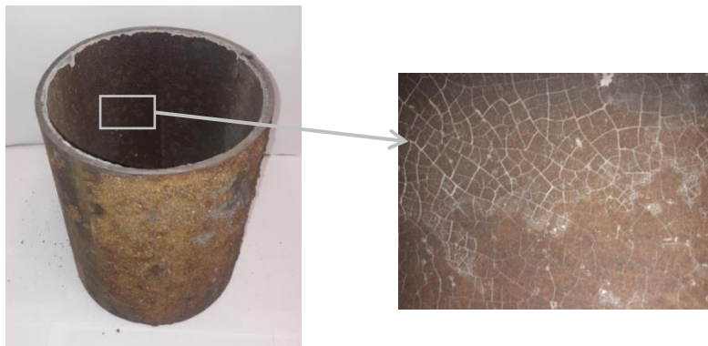
Figure 137 : Photographies d'une virole du tuyau de Nantes et de son revêtement intérieur
