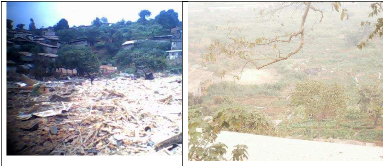
Image 7 : vue sur la zone précaire de Ntaba pendant et 8 ans après démolition
