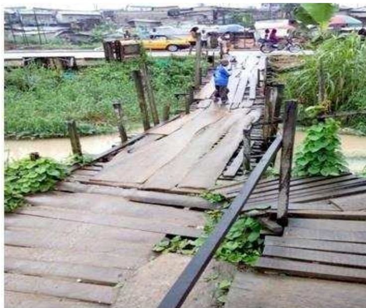
Figure 12 : Ouvrage de franchissement construit par le comité de développement à Makèpè
