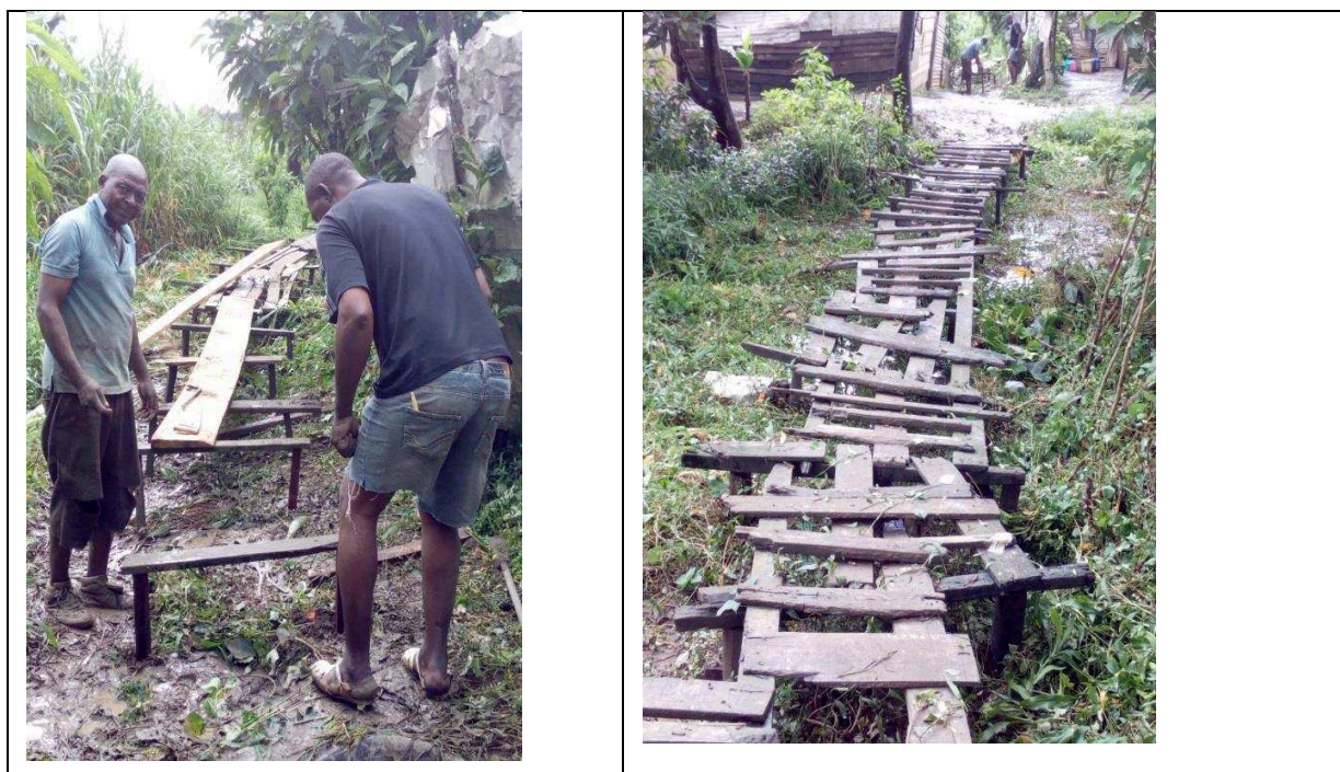
Image 11 : Construction d’un ouvrage de franchissement par le comité d’hygiène et de salubrité du quartier Makèpè
