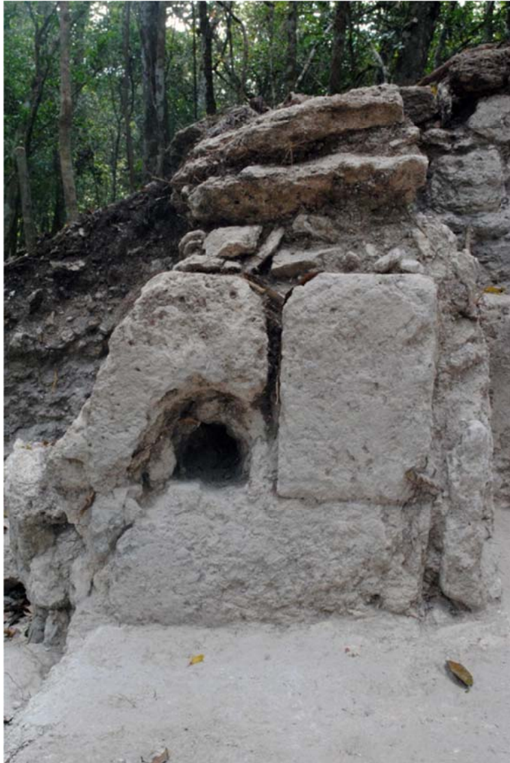
Figure 6.14 : jambage est de la Pièce 2 de l'Edifice 6O-8, avec une niche circulaire servant au système de fermeture de cet espace (Sion 2011)
