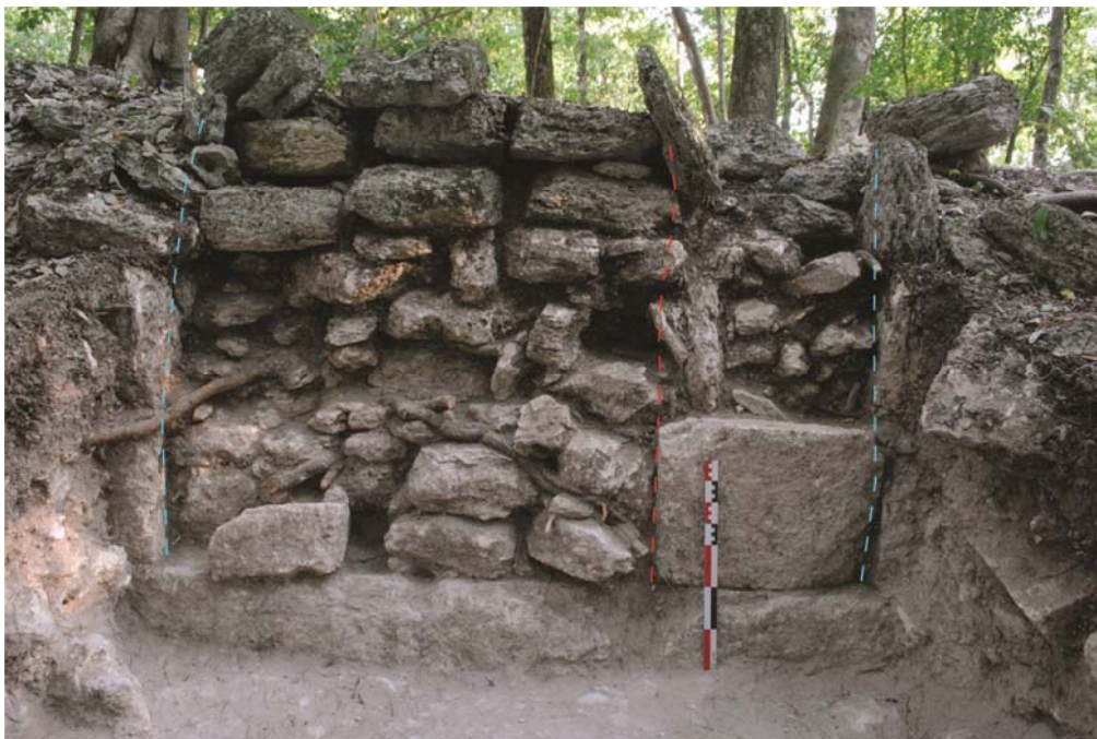
Figure 7.55 : vue depuis l'extérieur nord de la porte septentrionale de la Pièce 6O-43 Ouest, condamnée, avec la localisation de ses jambages originaux (pointillés bleus) et du massif ajouté à l'ouest (pointillés rouges) (modifié de Sion 2013)
