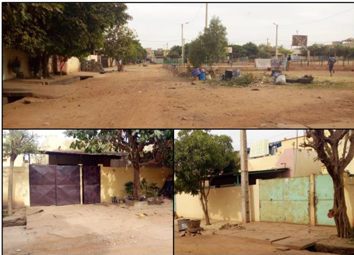
Figure 17. Logements sociaux à Yirimadjo
