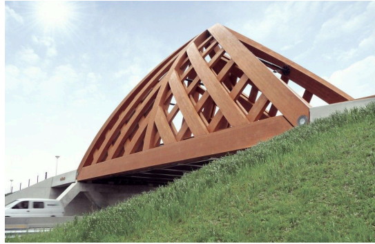
FIGURE 2.3 – Exemple d'utilisation du bois acétylé : construction de pont.
