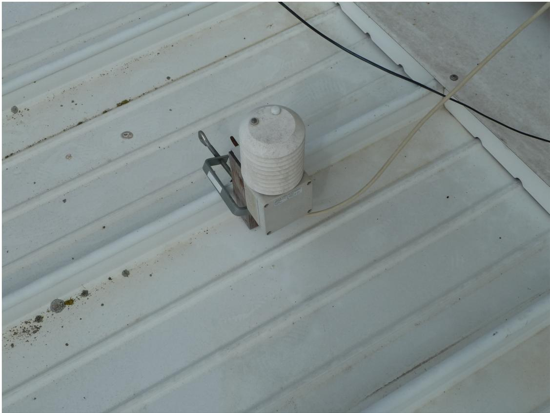
Figure 3.9 : Sonde utilisé pour mesurer la température extérieure
