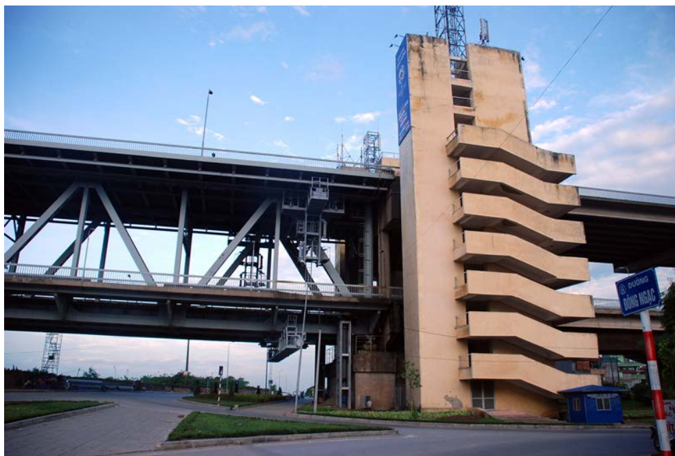
Illustration 1.5 : Le double niveau du pont Thăng Long.
