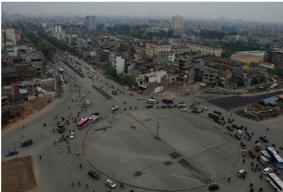
Illustration 10.5 : Intersection Thanh Xuân (en travaux)
