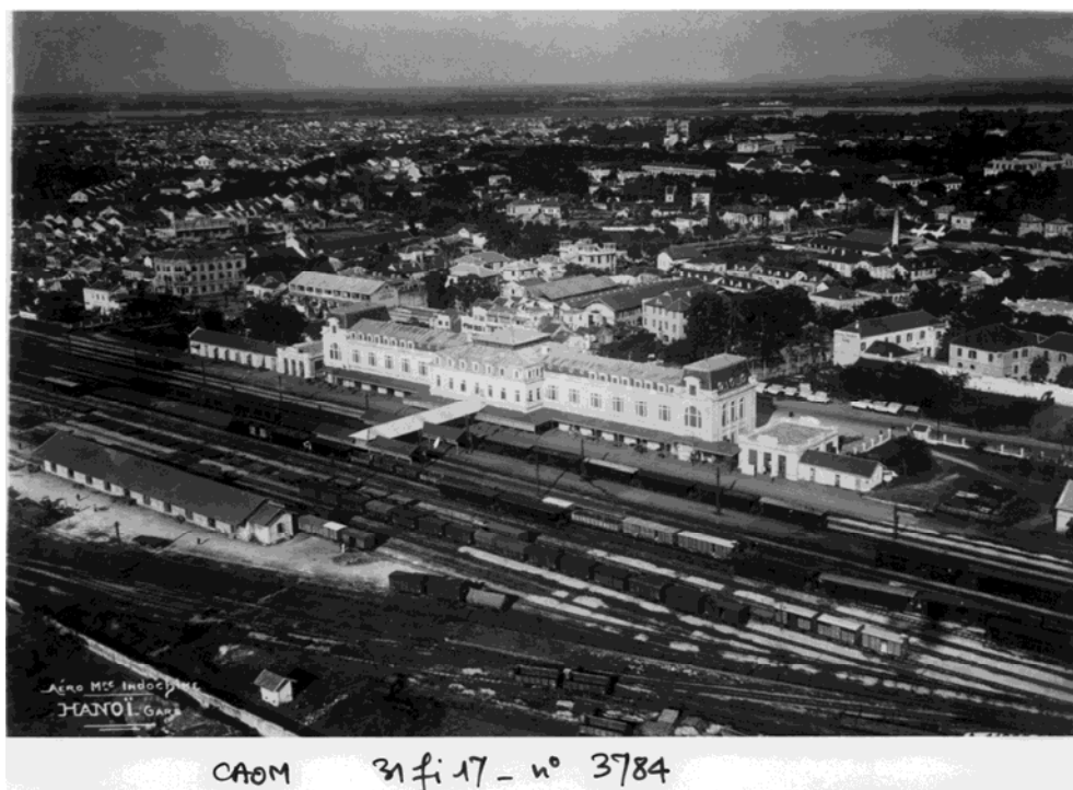
Vue aérienne de la Gare de Hanoi, au fond le fleuve Rouge (source : fond CAOM)
