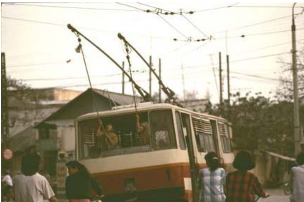
Bus trolley, deux hommes maintenant les câbles pour assurer l'alimentation électrique du véhicule (source : Archives de Tramoc, années 1980)
