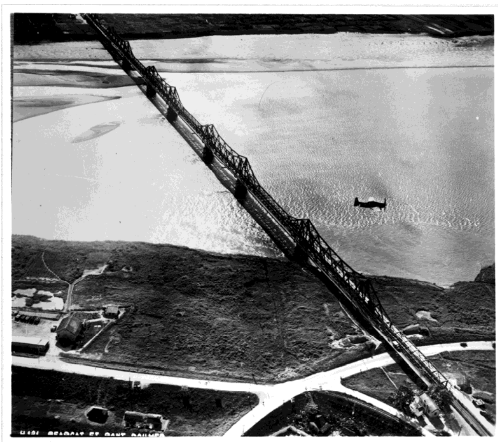
Vue aérienne du pont, rive droite. Cliché probablement pris dans les années 1950 durant la guerre d'Indochine (source : EFEO, O. Tessier)
