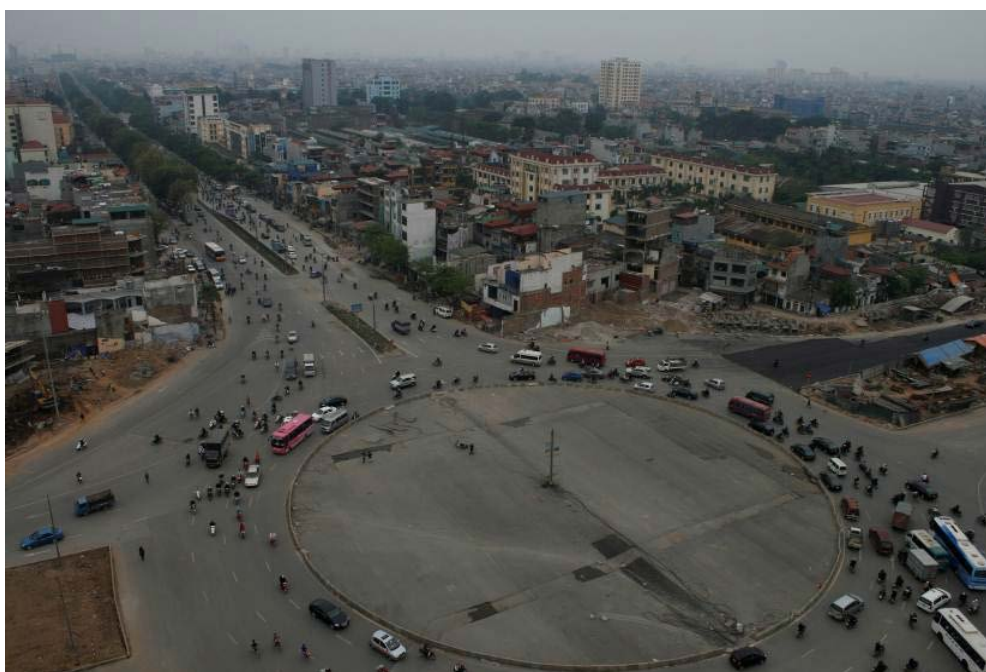
Illustration 10.5 : Intersection Thanh Xuân (en travaux)
