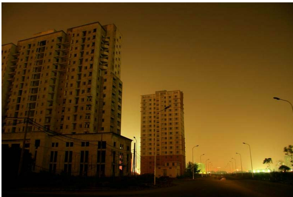
Illustration 9.1 : Construction du site de relogement de Nam Trung Yên, 2010
