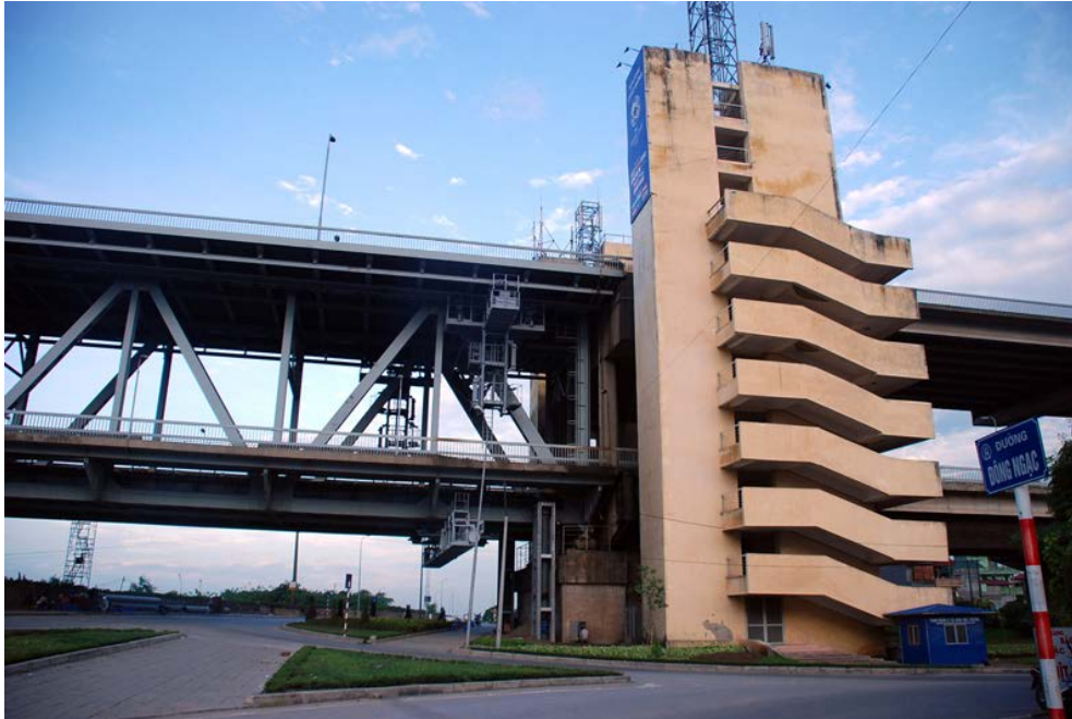
Illustration 1.5 : Le double niveau du pont Thăng Long.
