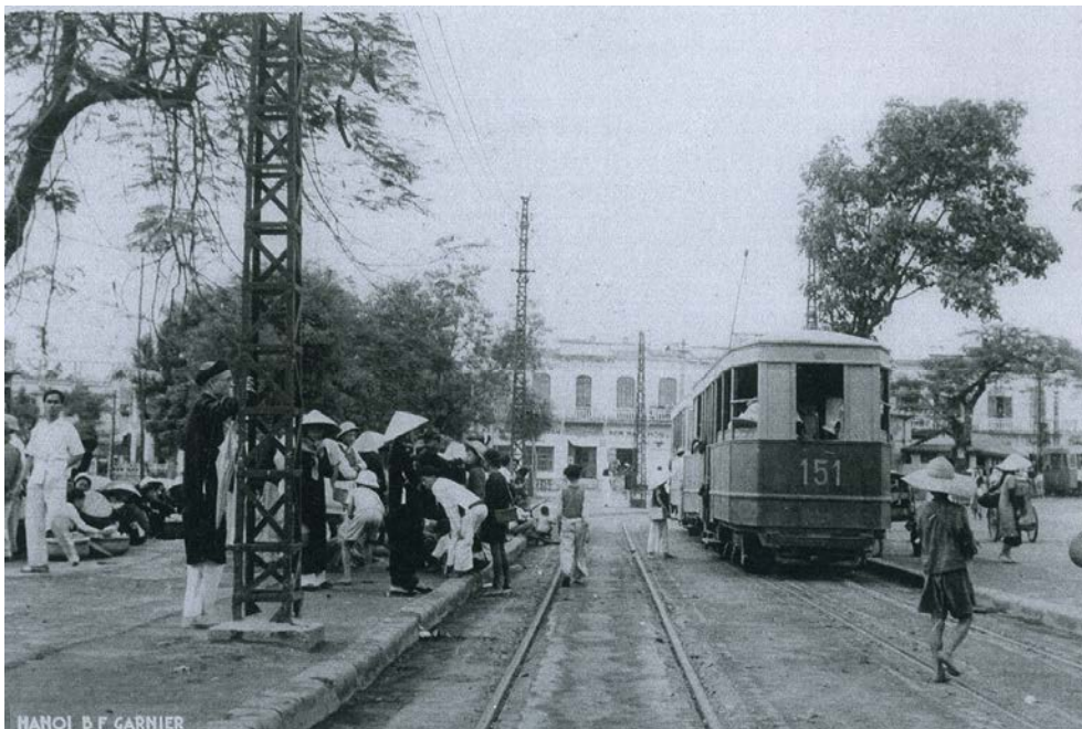
Station de tramway au nord du Petit Lac (source : cliché de B.F Garnier, Mission Etrangères de Hanoi)
