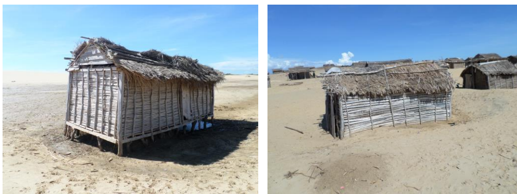
Figure 146 : Des cases à Fitsitike fabriquées avec des bois de palétuviers ( Rhizophora mucronata pour les piliers, Sonneratia alba pour les traverses) et Typha angustifolia (Andriatsiaronandroy, 2018)
