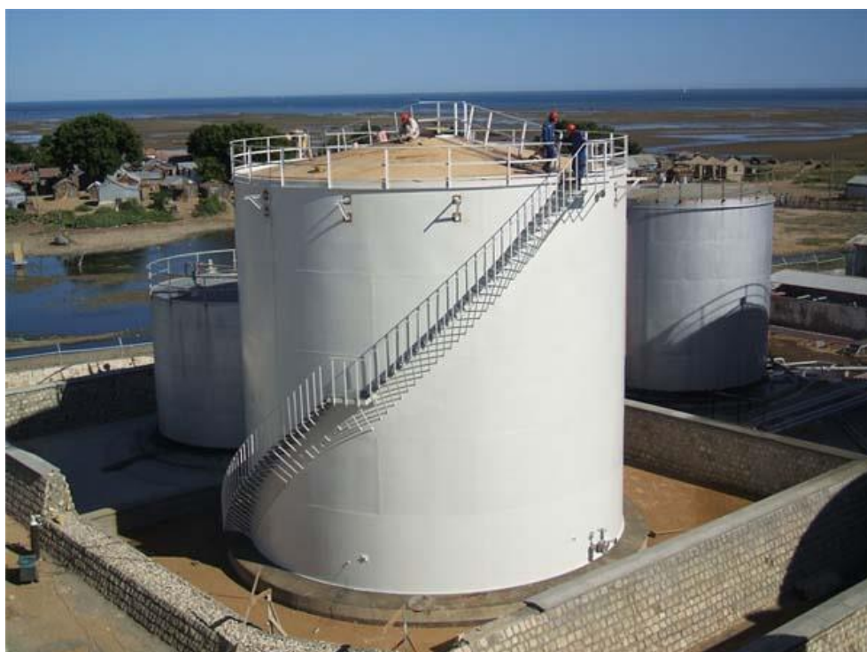
Figure 157 : Dépôts d'hydrocarbures de Logistique Pétrolier au nord d'Ankiembe (Systec Sarl Madagascar, 2007)
