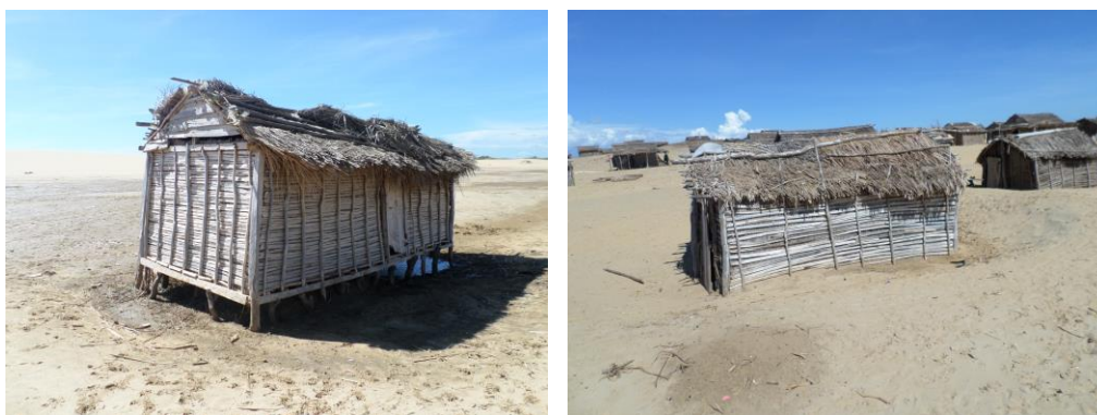
Figure 146 : Des cases à Fitsitike fabriquées avec des bois de palétuviers ( Rhizophora mucronata pour les piliers, Sonneratia alba pour les traverses) et Typha angustifolia (Andriatsiaronandroy, 2018)
