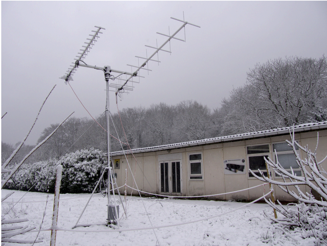
FIGURE D.12: Les antennes de la station sol construite à Meudon, par une froide journée de Janvier. La plus petite des deux antennes est l'antenne UHF fonctionnant à 435 MHz pour la réception des données du satellite. L'antenne la plus grande fonctionne en VHF, à 145 MHz, et est utilisée pour l'envoi des commandes vers le satellite.
