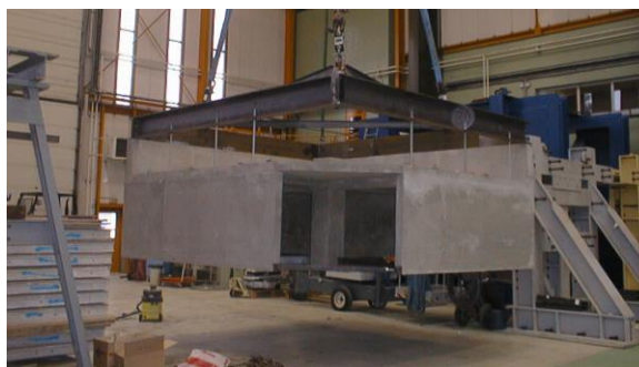
Figure 3.23 - Levage de la maquette P4 pour mise en place sur la table vibrante Azalée
