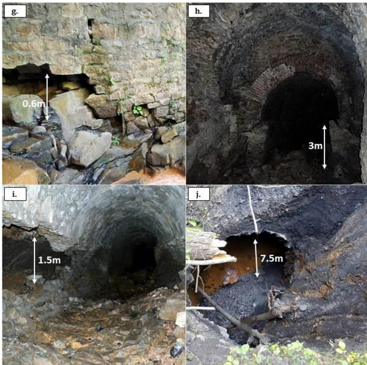
Figure 1. 21 : Photographies prises pendant l'été 2017: g) Chute de moellons dans le ruisseau couvert de Champclauson - 1 (La Grand-Combe, France), h) Déformation dans le ruisseau couvert Les Grottes – 1 (Bessèges, France), i) Effondrement des piédroits dans le ruisseau couvert de La Vieille Valette (Robiac-Rochessadoules, France), j) Effondrement dans le ruisseau couvert de Champclauson – 1 (La Grand-Combe, France).
