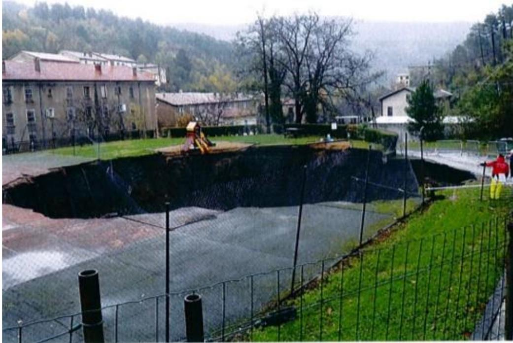
**Figure 0. 6 : Photographie de l'effondrement du ruisseau couvert Rochessadoule Amont à Robiac-Rochessadoule en 2012 (F.Vermeersch et al., 2012)**
