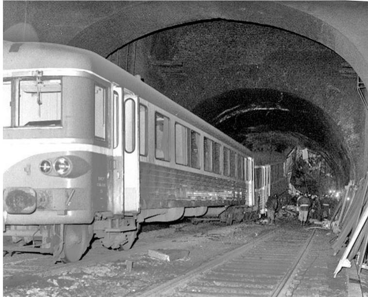
**Figure 0. 2 : Effondrement tunnel ferroviaire de Vierzy (Aisne) en 1972 (INVENTAIRE des TUNNELS FERROVIAIRES de FRANCE, n.d)**
