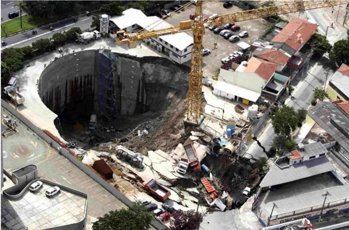
**Figure 0. 3 : Effondrement d'une station de métro en construction à Sao Paulo au Brésil en 2007, d'après (Barton, 2008)**
