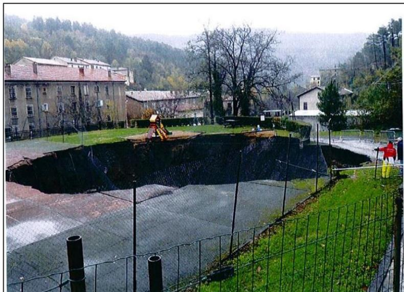
Fig.2. Photographie de l'effondrement du ruisseau couvert Rochessadoules à Robiac-Rochessadoules dans le Gard (GEODERIS 2012)
