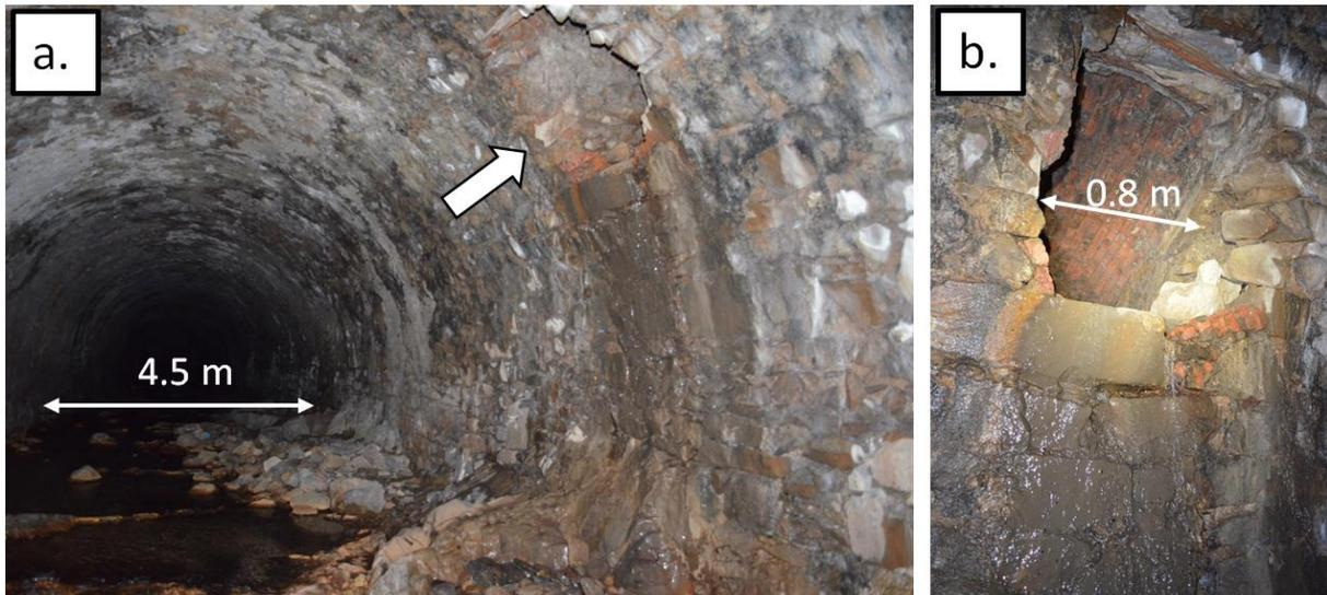
**Figure 1. 7. Photographies prises à l'intérieur du ruisseau couvert Rochessadoules amont par Mourey (2017) : 1) vue de l'intérieur d'un ruisseau couvert et présence d'un ruisseau couvert annexe (flèche blanche), b) zoom sur le ruisseau couvert annexe**
