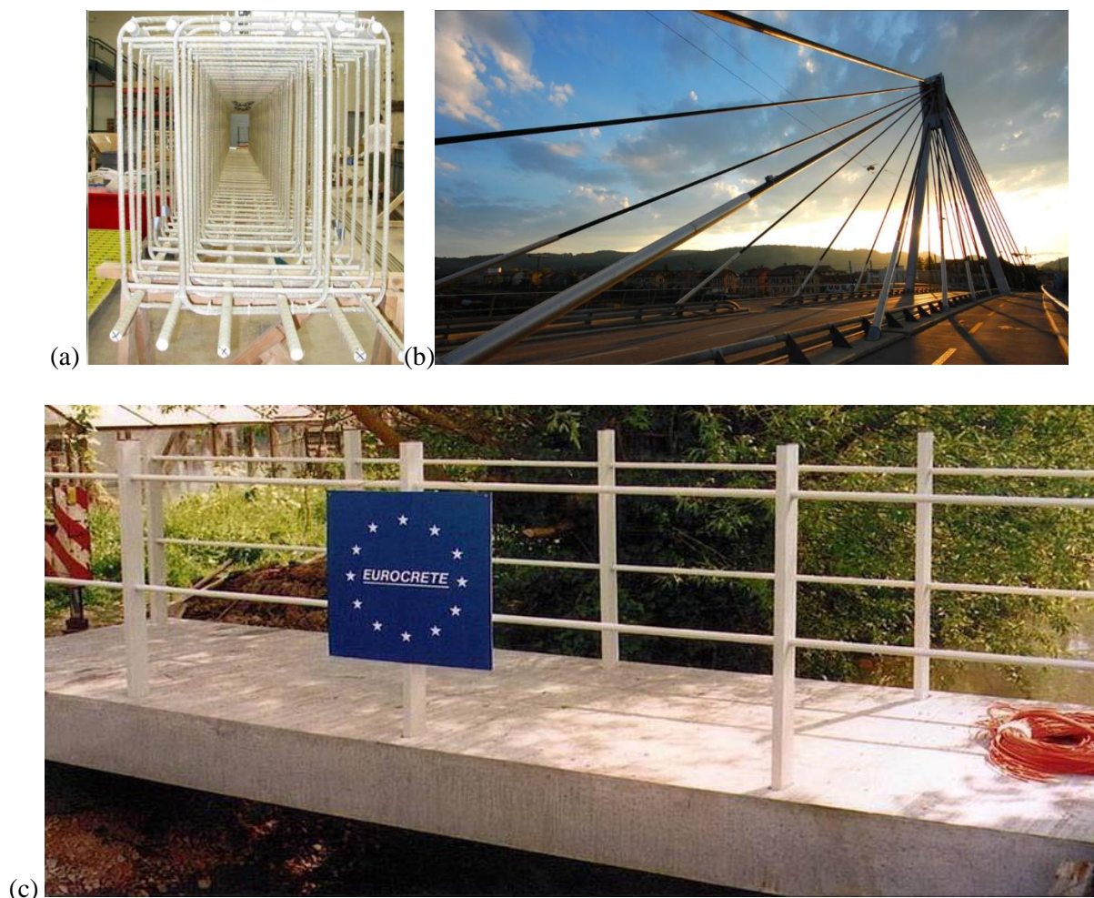
Figure I-6: Utilisation de composites pour la construction d'ouvrages neufs : (a) Cage de ferrailage pour un élément en béton armé et (b) pont avec des câbles en composites renforcés par des fibres de carbone (c) La première passerelle en béton en Europe réalisée uniquement avec des armatures composites (projet EUROCRETE) (Fib Bulletin 40 2007; Matthys 2017).
