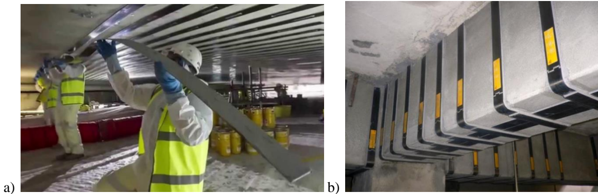
Figure I-2: Collage de plats composites : (a) Renforcement en flexion et (b) Renforcement en flexion et cisaillement [Sika Carbodur®].
