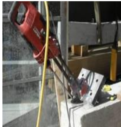
Figure I-5: Insertion de barres de composite dans un élément (Matthys 2017).
