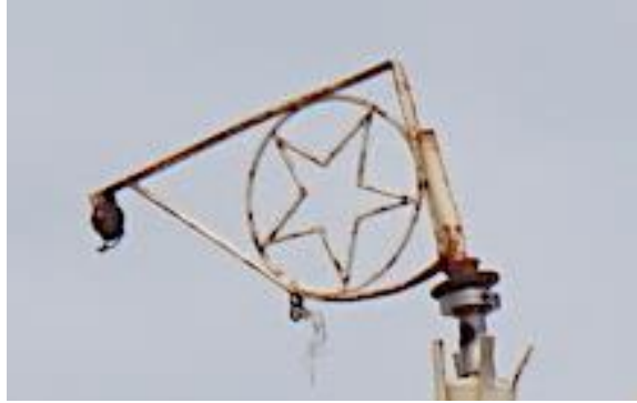
Potence avec axe pivotant à 360° du nargoulan (sans l'étoffe ici). Saint-Paul, 2019.
