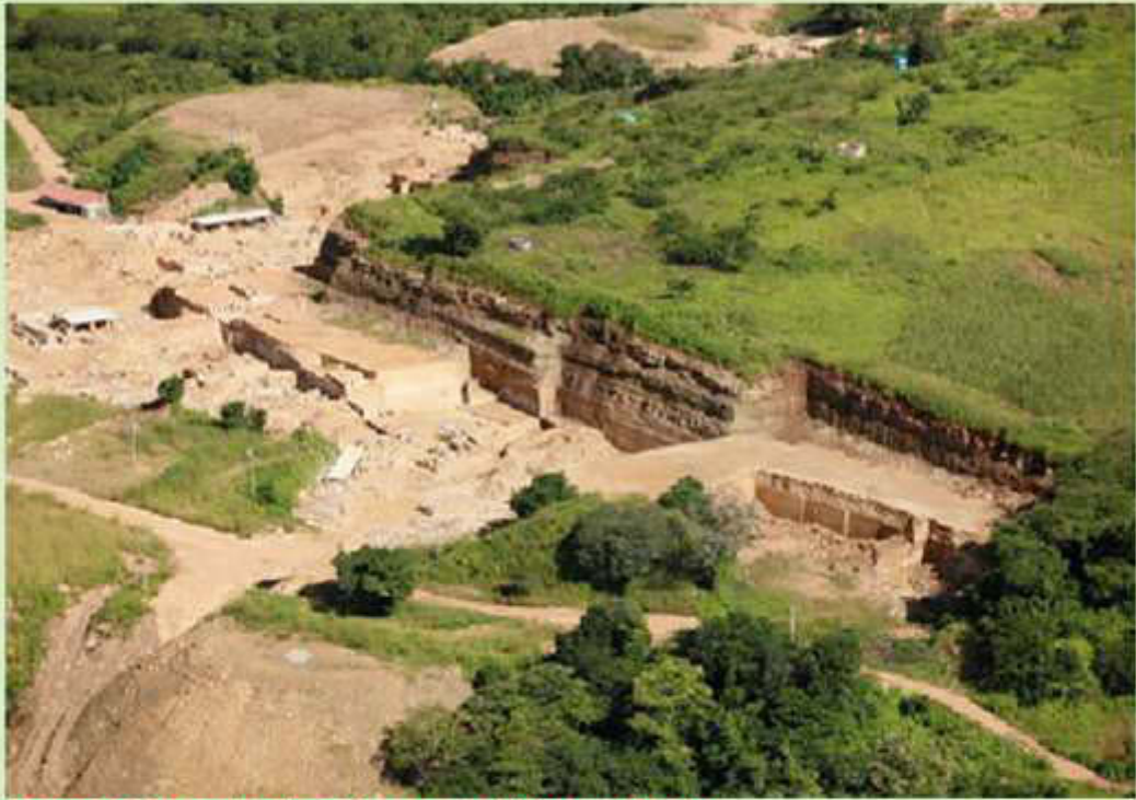
Mina de Extração da Pedra cariri / Nova Olinda
