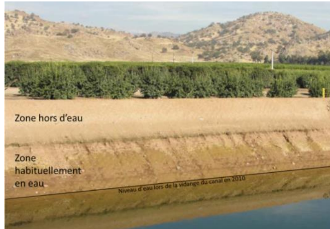
Figure I.31 : Photographie lors de la vidange en 2010 du canal Friar-Kern d'une des berges traitée à la chaux (Herrier et al., 2012).
