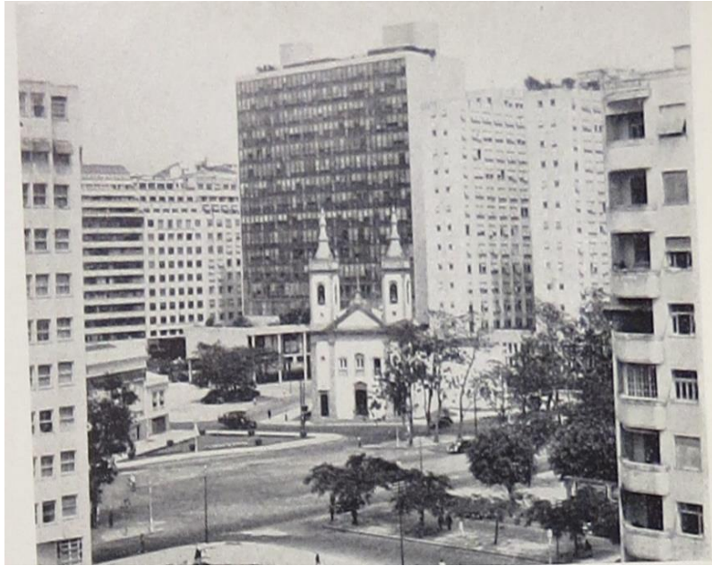
Fig. 791 : Rio de Janeiro – La petite église Santa Luzia de vieux style portugais et le Ministère de l'Éducation au milieu des grand immeubles modernes". Photo-Monde, Mars 1954
