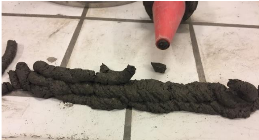
Figure II-3. Blocage de la buse à cause du durcissement du mortier
