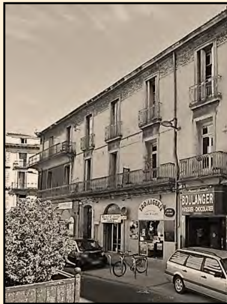
Immeuble du n°5 place de l'Observatoire (Actuelle place Laissac, à MontpellierErreur ! Signet non défini.), Cliché IL, 2018
