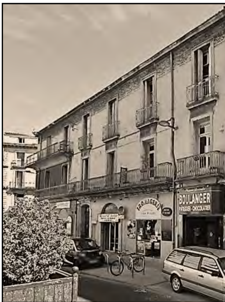
Immeuble 5 place de l'Observatoire à Montpellier, 2018, Cliché I. LABORIE
