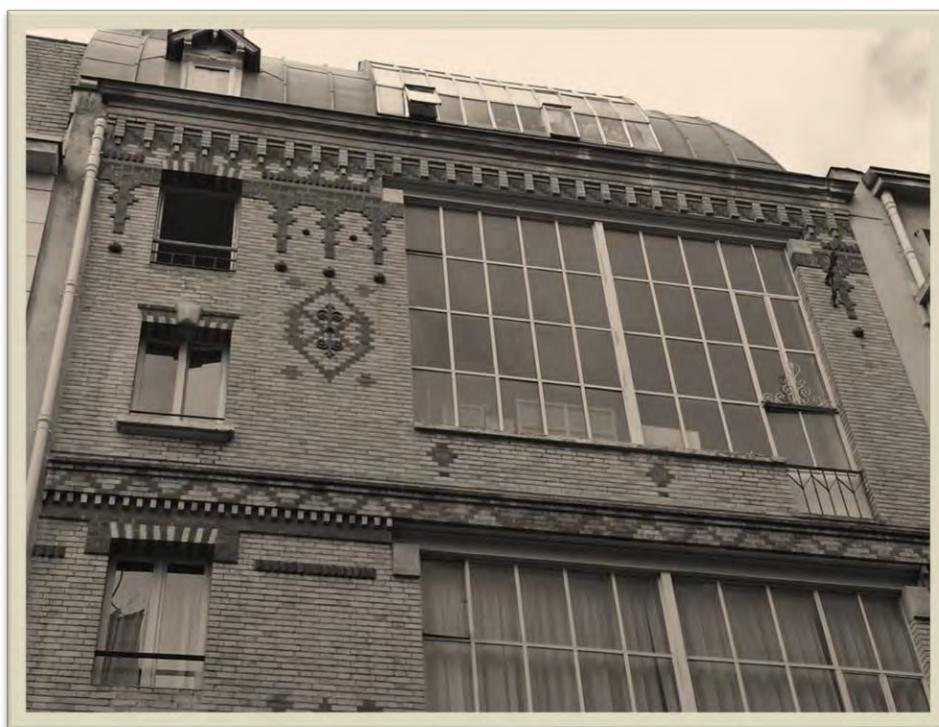
Immeuble d'atelier 5 bis rue Jadin 1 , cliché réalisé par FP en avril 2016
