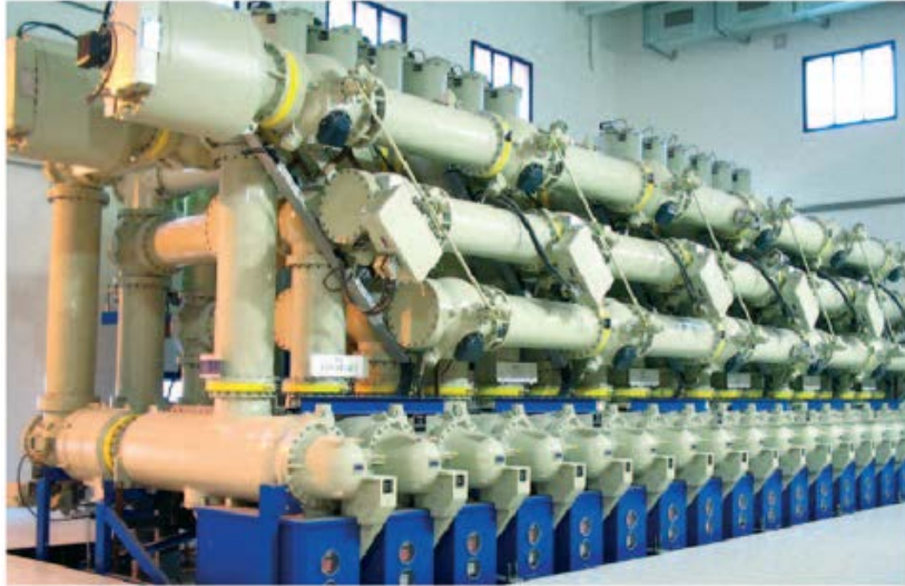
FIGURE 0-3 – Exemple de PSEM proposé par General Electric Grid Solutions : un isolant solide est installé à chaque jonction jaune.
