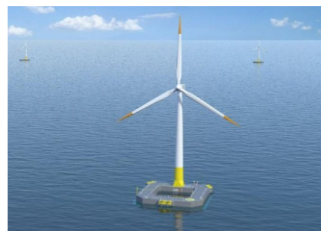
(d) Floating wind turbine
