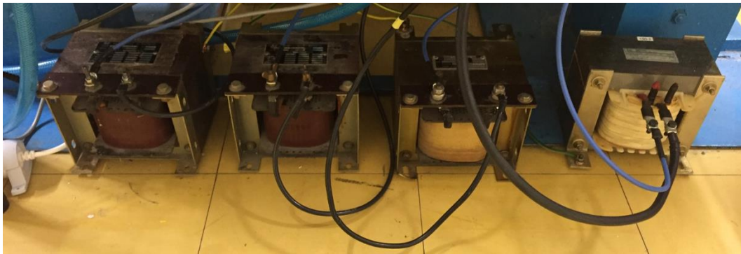
Figure 4.18 : Bobines de lissage du laboratoire pouvant être utilisées
