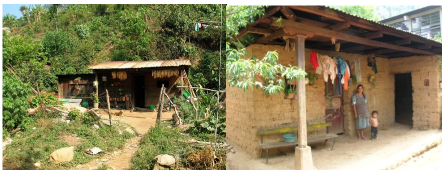
Série photo 3. Maisons en adobe enduit et sol en terre (G) et au sol cimenté (D)
