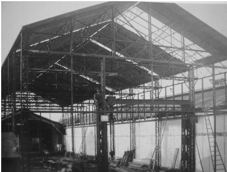
Construction du plateau B en 1927.
