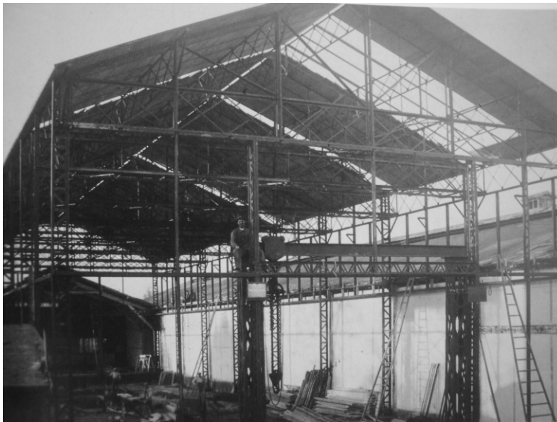
Construction du plateau B en 1927.
