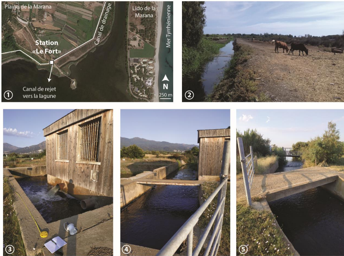
Figure 13: Géométrie d'une station de pompage de la plaine de la Marana : cas de la station du Fortin avec 1) une vue aérienne du réseau de canaux et de la station « Le Fort », 2) l'environnement et le canal à quelques mètres à l'Est de la station de pompage, 3) le bassin de rejet de la station, en cours de pompage, 4) le canal perpendiculaire au bassin de rejet collectant les eaux pompées et 5) la continuité de ce même canal vers la lagune.
