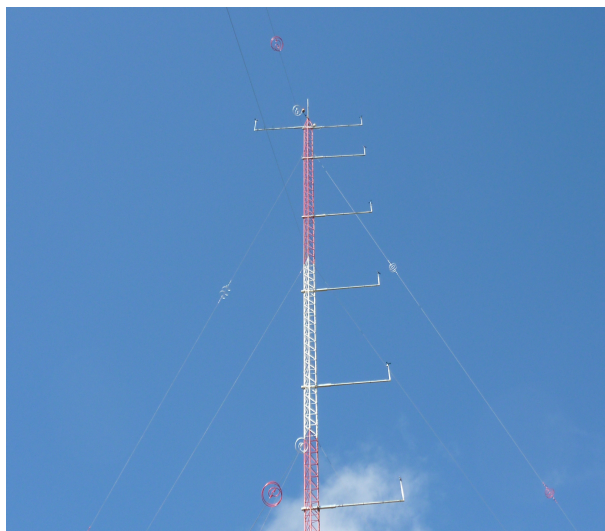
FIGURE 1.1 – Pylône de mesure
