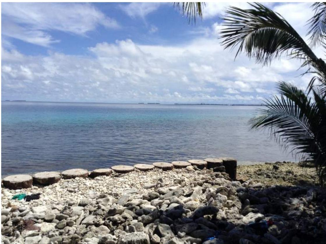
**Fig.50** Digues de barils de pétrole rempli de béton à Fongafale, 2015 (Photographie F.Gutiérrez)
