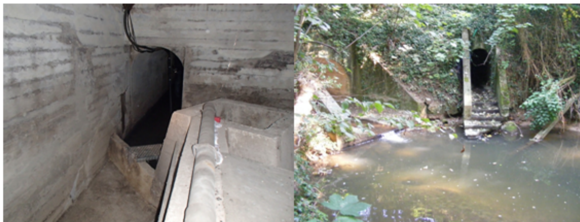
Figure 52. Photos de la chambre de déversement (sur la gauche) et de l'embouchure de la canalisation de déverse donnant sur le milieu naturel (sur la droite).
