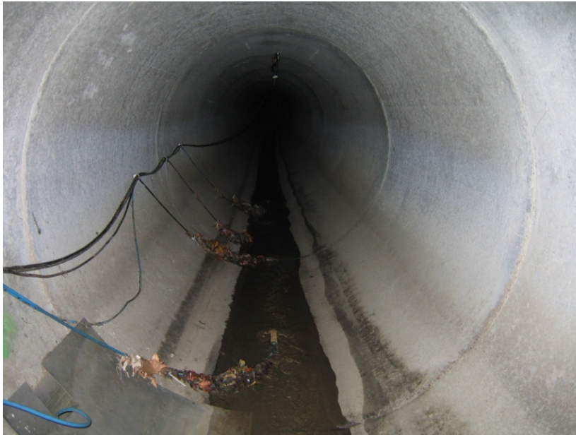
Figure 33. Canalisation de chassieu.
