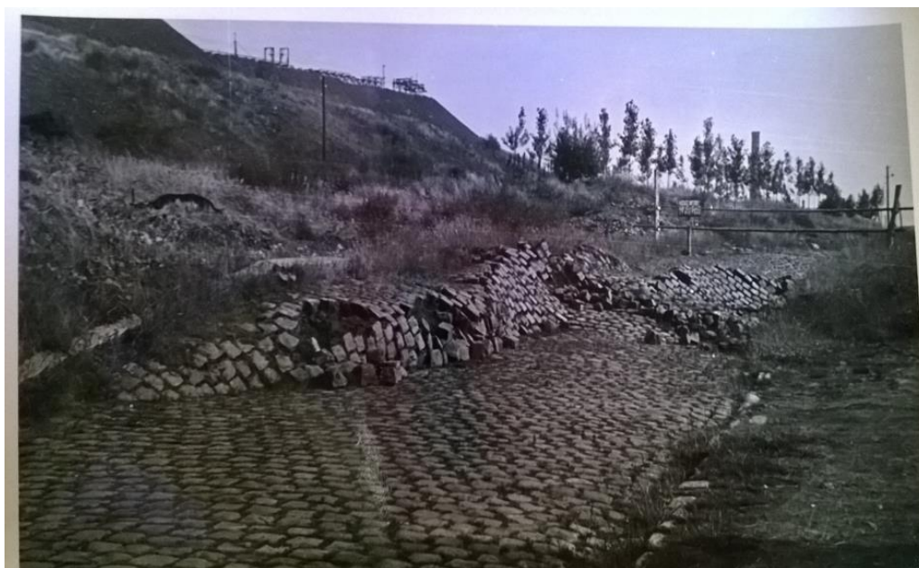
Figure 9 : Soulèvement de la rue de Jemappes à La Bouverie, 1951. Ce soulèvement est dû à une poussée du terril du Grand Trait des Charbonnages Belges situé à proximité (Source : SAICOM, S.A. John Cockerill. Division des Charbonnages Belges et d'Hornu et Wasmès, 55).
