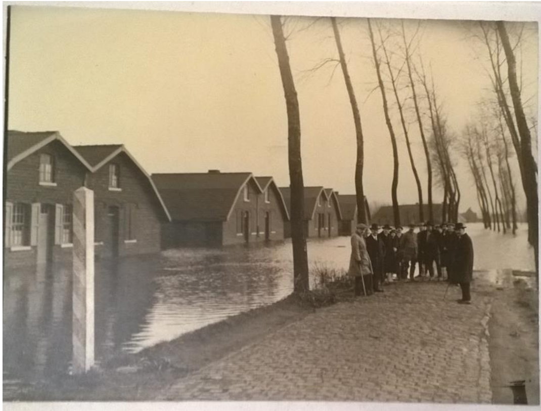
Figure 10 : Inondations à Hensies en 1926. Les affaissements miniers causés par les travaux souterrains des Charbonnages d’Hensies-Pommeroeul conjugués au rejet de schlamms dans la Haine rendent vulnérable aux inondations cette partie de la vallée de la Haine (Source : SAICOM, Charbonnages d’Hensies-Pommeroeul , 606).
