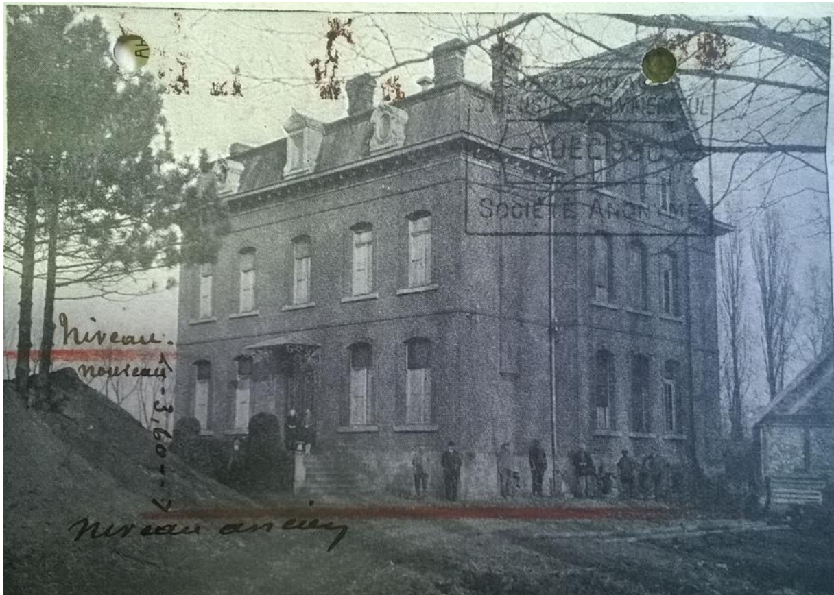
Figure 23 : Travaux de relèvement du château Peñarroya à Noyelles-Godault, 1929 (Source : SAICOM, CHP, 1354).
