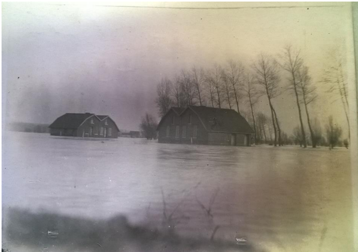
Figure 25 : Maisons inondées à Hensies à la suite des inondations de la Haine, hiver 1925-1926 (Source : SAICOM, CHP , 606)
