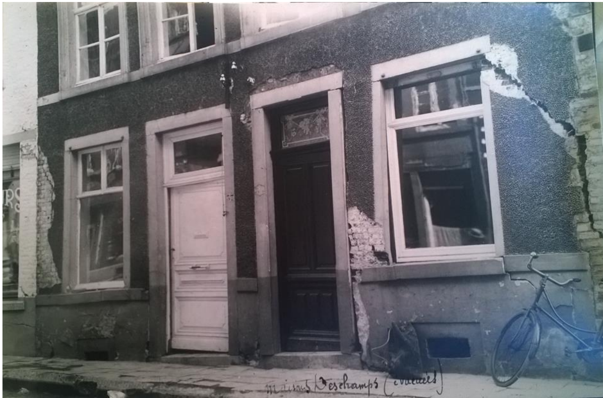
Figure 28 : Maison de la rue Saint-Roch à Gosselies évacuée par ses habitants, 1931 (Source : AGR, Administration des Mines. 3 e série, 485 ).
