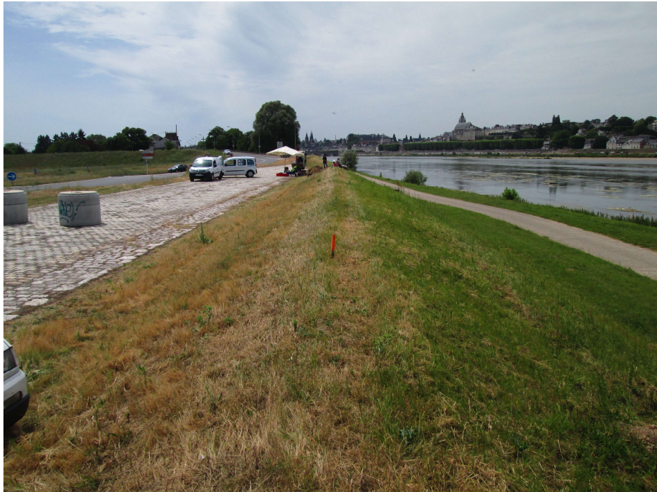
Figure 3 : Déversoir de la Bouillie sur une digue de la Loire (Blois, 41). On distingue au premier plan, la partie en terre faisant office de fusible, la zone perreyée devant résister à la surverse.
