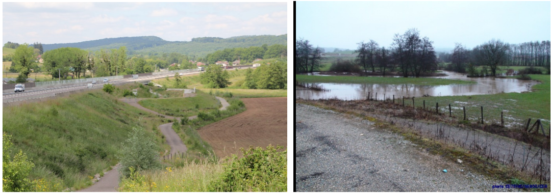
Figure 36 : Vue du remblai de Héricourt. À gauche, en mai 2015 : le remblai forme le bassin de rétention des eaux pluviales en bordure de la route déviant Héricourt entre Lure et Belfort. À droite, en janvier 2013, la Lizaine qui se situe en pied de remblai est sortie de son lit et inonde partiellement les champs. La nappe phréatique est au niveau du terrain naturel. La photo est prise depuis le haut du remblai.
