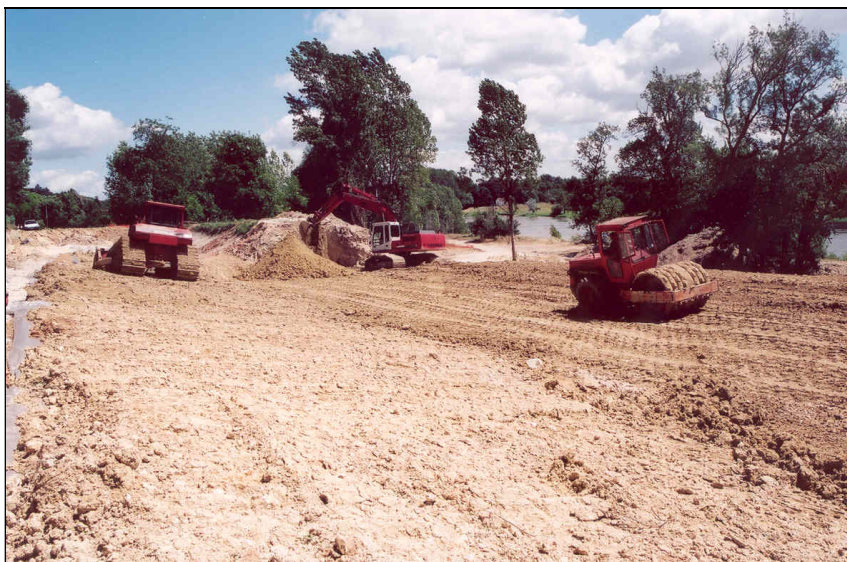
Figure 69 : Réfection de la digue du canal de Berry à Trevety (36) –2004
