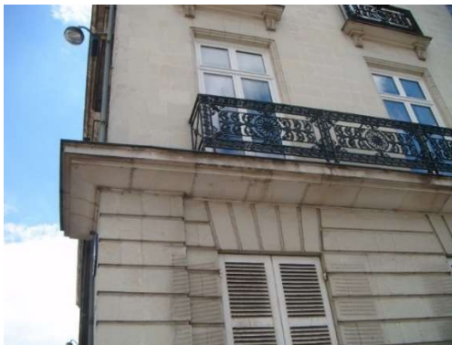
Hbt 33, Photo 5 du Tronçon 1 : balcon en fer forgé rue du Roi Albert
