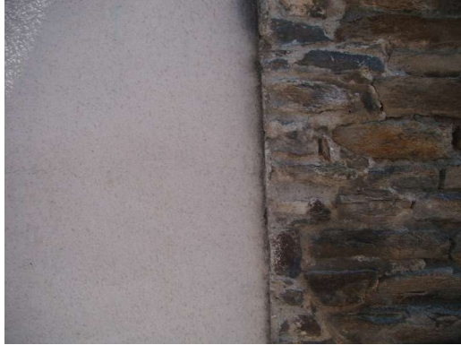
Hbt 28, Photo 2 du tronçon 2 : un mur du lycée Livet, rue de l'amiral Ronarc'h
