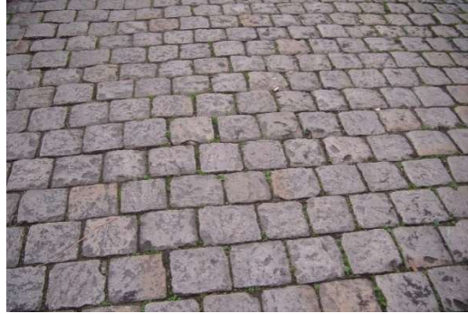
Figure 19 : Habitant 51, Photo 2 du tronçon 1 : pavés place Roger Salengro (place de la préfecture) – habitant ayant passé toute sa jeunesse à Bouvron (44)
