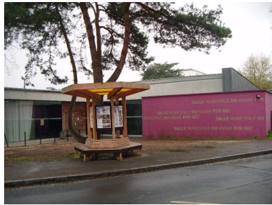
Hbt 3, Photo 1 du T3 : La salle municipale du Radar Pin-Sec
