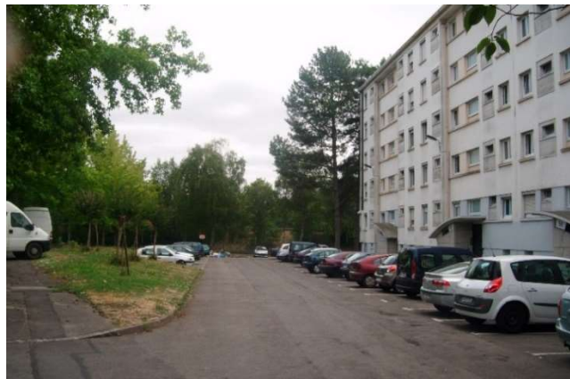
Figure 25 : Habitant 31, Photo 6 du tronçon 3
