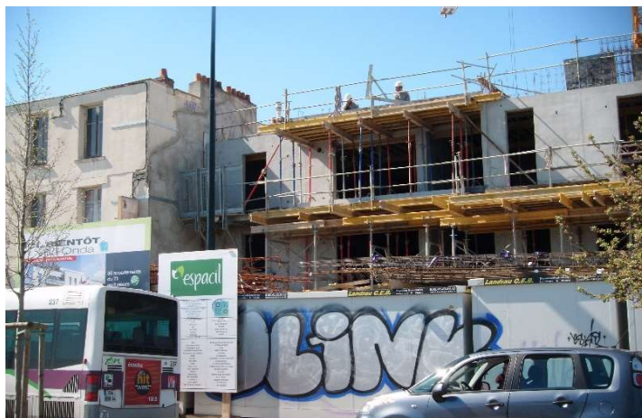
Figure 14 : Habitant 1, Photo 1 du tronçon 3 : immeuble en construction boulevard Jules Verne au niveau de l'arrêt de bus Chocolaterie :
