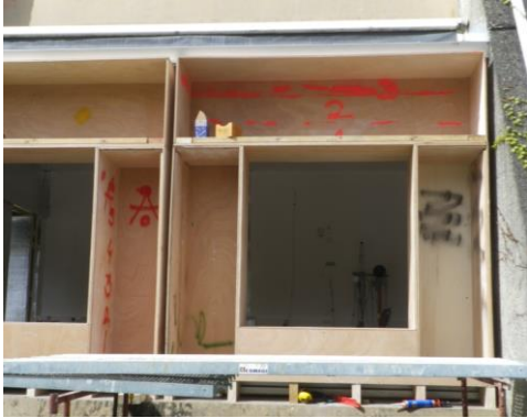
Figure III-9. Mise en place des caissons en bois avec renfort au niveau des linteaux.
