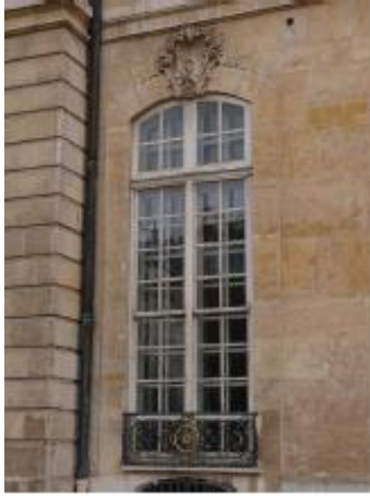
Figure I-6. Double-fenêtre extérieure à guillotine à l'Hôtel de Biron. Crédits : Luc Goupil.
