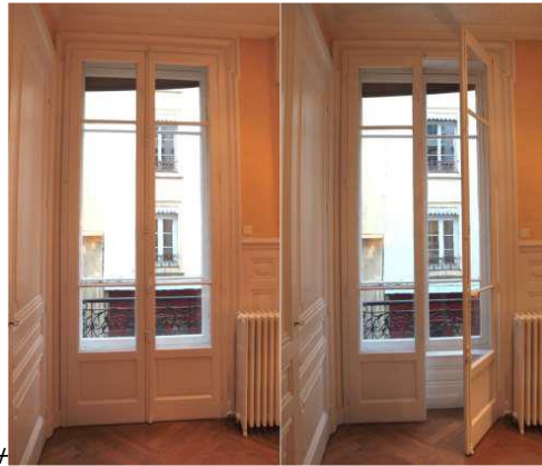
Figure I-8. Photos d'une double-fenêtre dans un bâti XIX e siècle lyonnais. Crédits: Nathalie Sandt.
