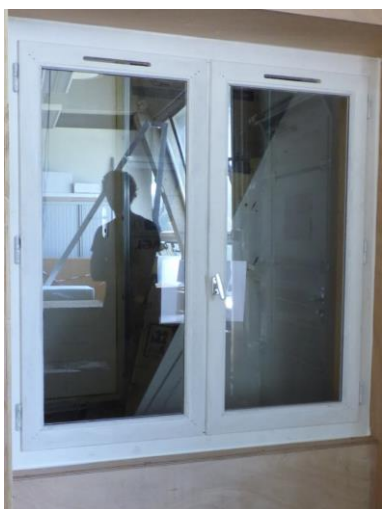
Figure III-4. Photo des fenêtres extérieures en simple vitrage.
