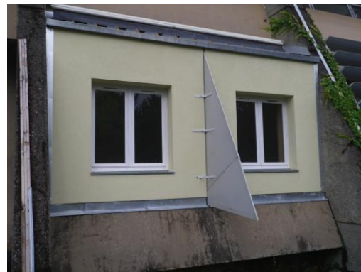
Figure III-12. Photo de la façade extérieure de la cellule expérimentale HYBCELL.
