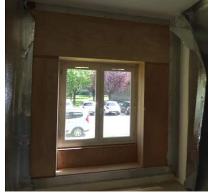
Figure III-10. Vue intérieure avant la pose de la fenêtre intérieure et de la peinture blanche.
