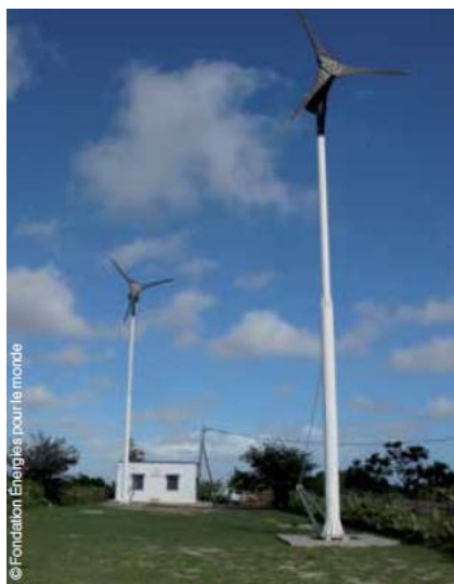
Figure 16: deux éoliennes de 6 kW à Ambondro à Madagascar [25] et ressource en vent du continent africain tirée de [84]
