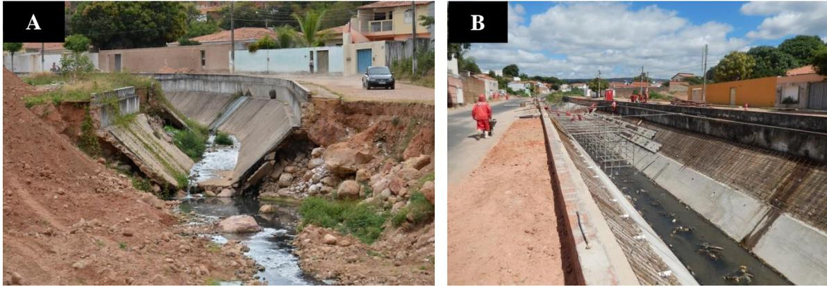
**Figure 5.30.** Le canal du Rio Granjeiro et sa reconstruction après la crue de janvier 2011. **A.** Destruction partielle après la crue éclair, montrant l’insertion sans fondations dans du matériel de terrasse non consolidé, ainsi que la minceur des plaques de béton. **B.** Reconstruction en juin 2013, avec pose de matériel compacté entre la paroi en béton et le substrat de l’avenue latérale. Quartier Pimenta. Photos : A.O. Magalhães.
