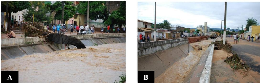
**Figure 2.10.** Écoulements de fin de crue et embâcles dans le Rio Granjeiro. Photos : H. Maia et W. Vieira, 2011. **A** : Passerelle détruite et partiellement emportée, centre-ville (28/01/2011). Photo H. Maia et W. Vieira. **B** : Écoulement turbulent et embâcle de blocs de béton, aval de l'église Nossa Senhora de Fátima (28/01/2011). Photos H. Maia et W. Vieira.
