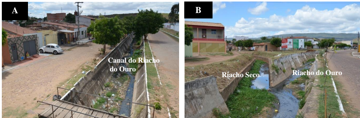
Figure 1.15. A. Le chenal bétonné du Riacho do Ouro dans le centre-ville de Barbalha. B. Confluence avec le chenal partiellement busé (à l'amont) du Riacho Seco. Photos : A.O. Magalhães, 2011.
