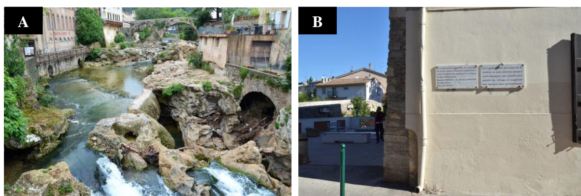
Figure 7.6. La Nartuby à Trans-en-Provence. A. Les cascades et le Pont Vieux, à l'arrière-plan. B. Plaque commémorative de l'inondation du 15 juin 2010, indiquant également la hauteur d'eau atteinte lors des crues de 1827 et 2010. Photos : A.O. Magalhães, mai 2012 et septembre 2013.
