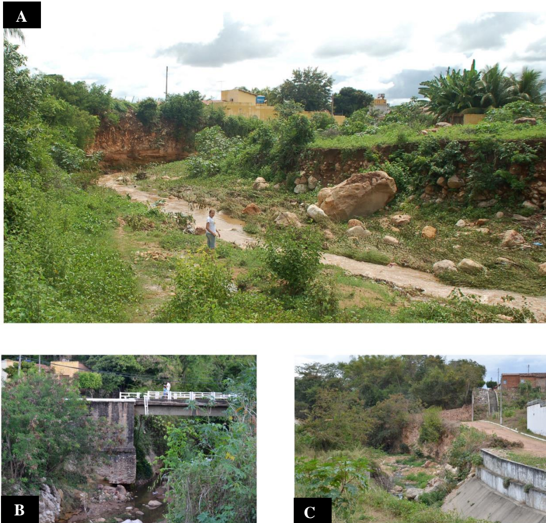
Figure 2.11. Le Rio Granjeiro à l'amont du canal. Photos : JP. Peulvast/A.O. Magalhães, 2011. A : Aval du pont de Lameiro. Coupes dans l'épaisse terrasse de coulée de débris qui se poursuit jusqu'au centre-ville et dans son substrat de grès tendres (Formation Rio da Batateira). Le plus gros bloc dépasse 5 m de longueur. B : Sapement d'une des piles du pont de Lameiro, août 2011. C : Entrée amont du canal (août 2011). Matériaux prêts à être mobilisés par les crues suivantes.
