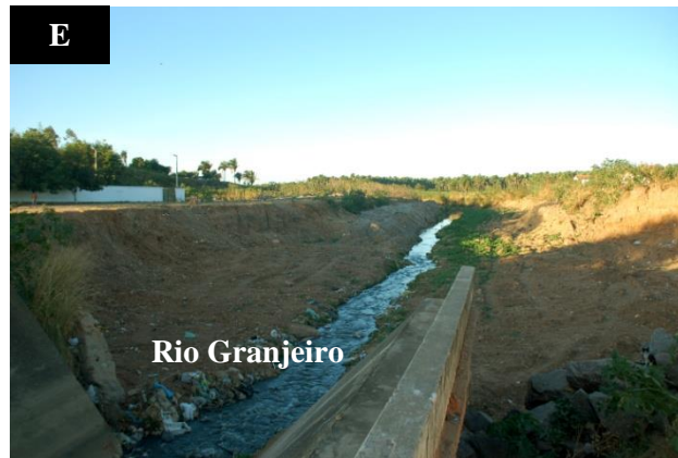
Figure 1.14. Le Rio Granjeiro à Crato. A. Partie amont du bassin-versant, depuis Belmonte. B. Source du Rio Granjeiro. C. Partie moyenne de la vallée du Rio Granjeiro près de la confluence du Riacho das Piabas, quartier Lameiro. D. Le Rio Granjeiro canalisé en centre ville, depuis Seminario. E. Partie aval du Rio Granjeiro, à l'exutoire du chenal bétonné. Photos : A.O. Magalhães/J.P. Peulvast, 2007 et 2014.
