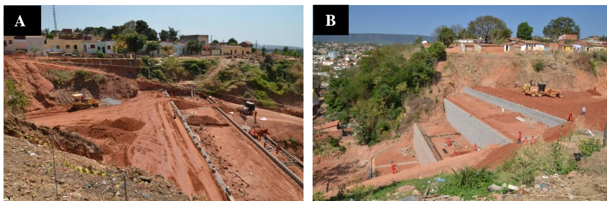
Figure 5.33. Travaux d'aménagement de la voçoroca du quartier Seminário. Photos : A.O. Magalhães, 2014.
