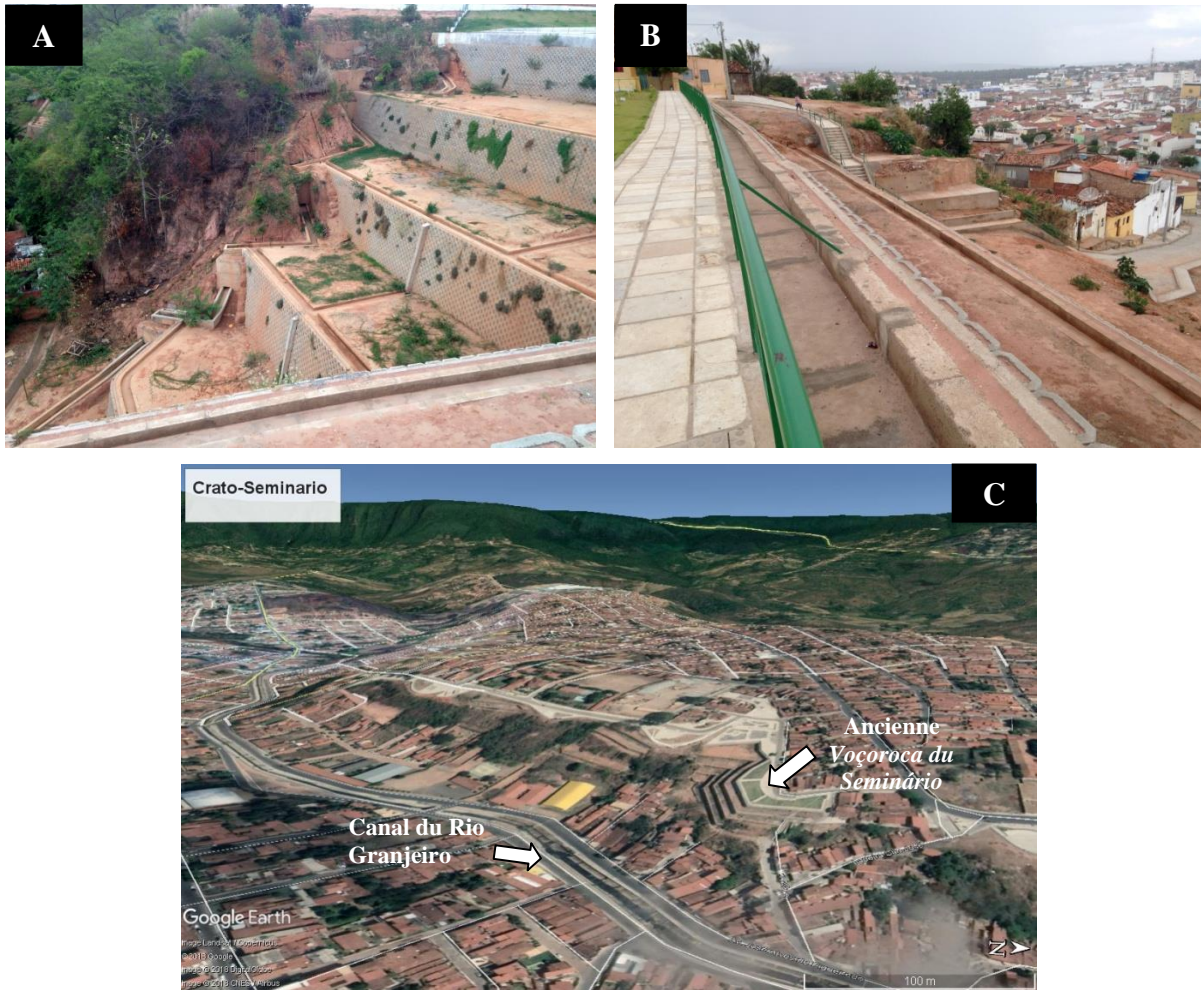
Figure 5.34. Les aménagements de la voçoroca du quartier Seminário en janvier 2016. A,B. Photos A.O. Magalhaes, 2016. C . vue perspective, image Google Earth, 2018.
