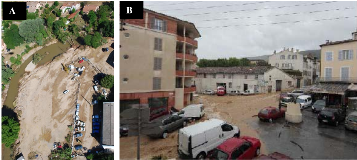
Figure 7.10. La crue du 15 juin 2010 à Draguignan. A. Quartier des Incapis, rive droite de la Nartuby (après la crue). B. Vallon de la Rialle, Boulevard de la Liberté. (Source : SAFEGE, 2013).
