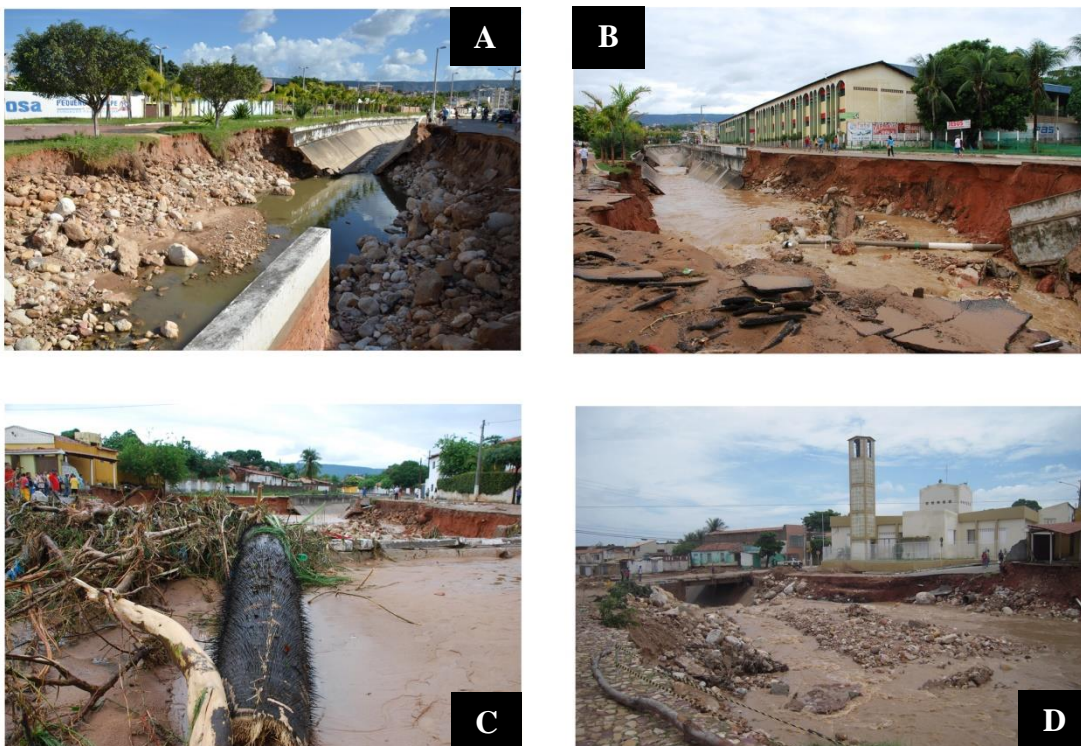
Figure 2.8. Le canal du Rio Granjeiro après la crue du 28 janvier 2011. Photos : J.P. Peulvast/ A.O. Magalhães/ H. Maia et W. Vieira.
