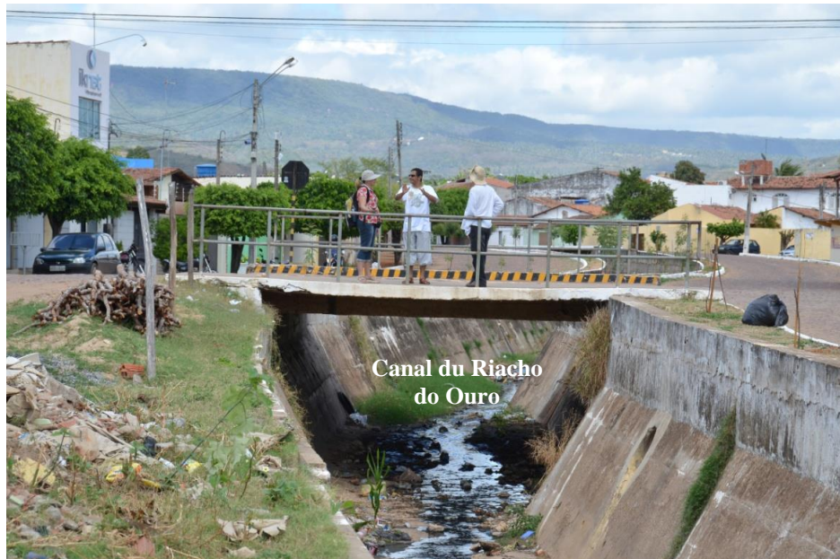
Figure 4.6. Le chenal bétonné du Riacho do Ouro, Barbalha. Photo : J.P. Peulvast, 2011.
