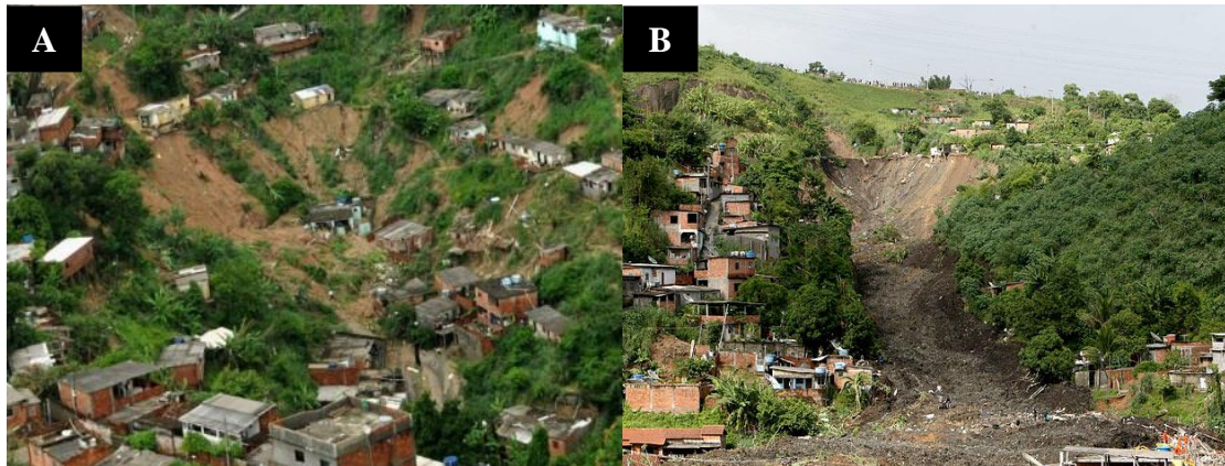
Figure 6.16. Entonnoir (cicatrice de glissement) et langue de débris formés à Niterói après des glissements provoqués par les pluies d'avril 2010. (Source : http://noticias.r7.com/04/01/2011 ).
