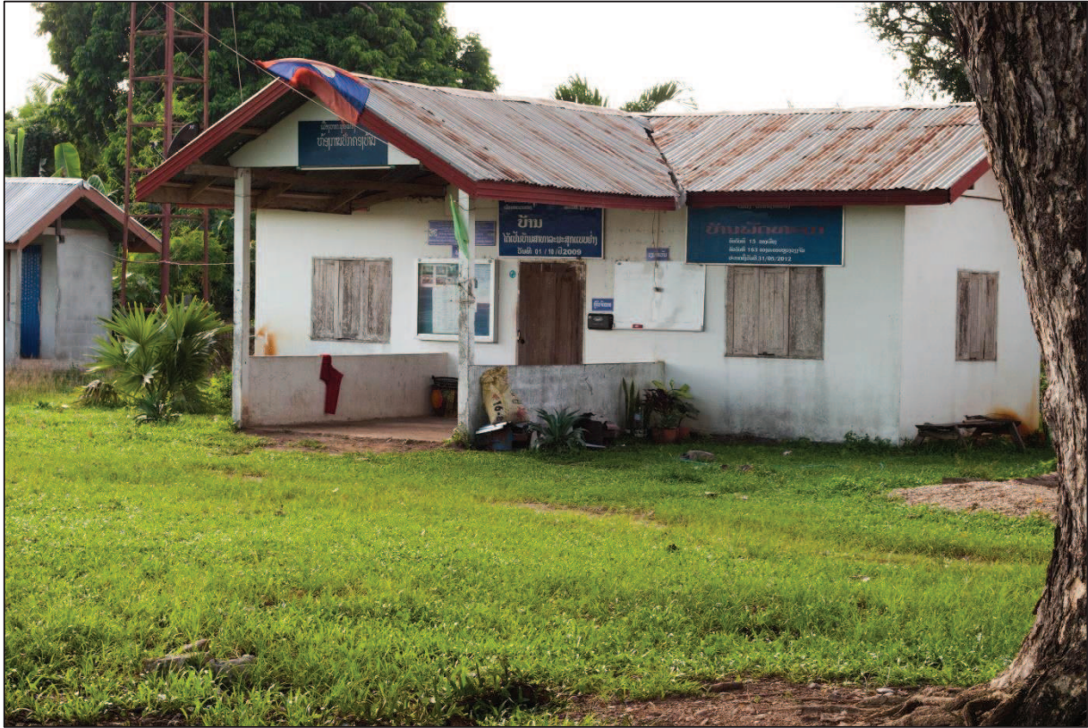
Figure 8. Bureau d'administration du village (hong kan pokkhong ban), Ban Na Daeng (B. Le Saint : photographie modifiée en accord avec l'exigence d'anonymat des lieux et des personnes).
