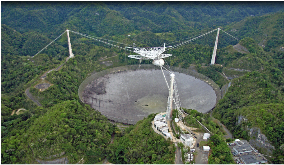
Figure 41 – Radiotélescope de l'observatoire d'Arecibo (Porto Rico). Le collecteur primaire sphérique est construit dans l'enceinte d'une dépression naturelle et le receveur secondaire, sur lequel se situe les réflecteurs secondaire et tertiaire ainsi que les antennes receveuses, est suspendu à 150 mètre au dessus.
