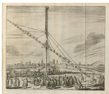
Figure 48 – Gravure sur bois de la lunette de Kepler de 46 mètres (150 pieds) construite par Johannes Hevelius en 1641. (Source : Johannes Hevelius, Machinae Coelestis , 1673 ; numérisation université Carnegie-Mellon)
