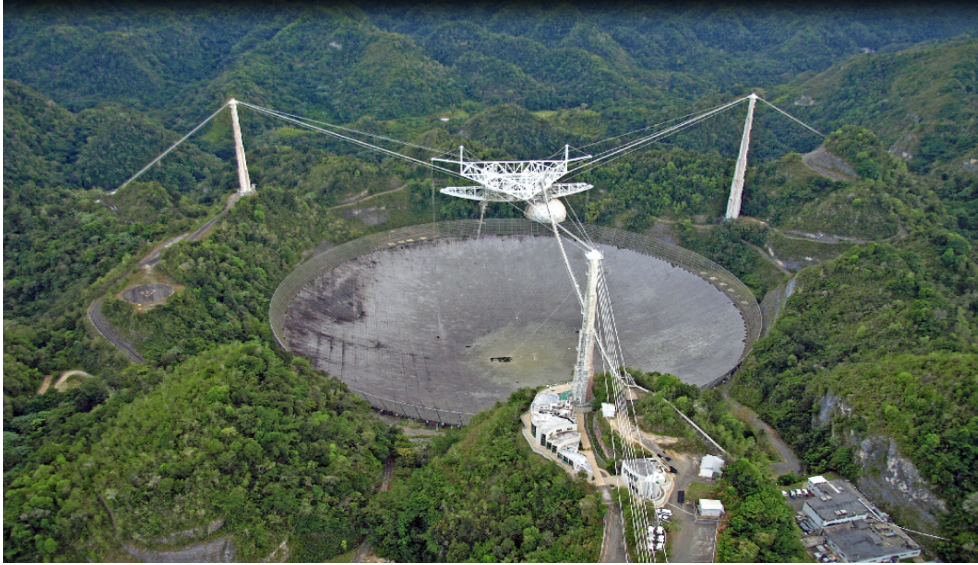
Figure 41 – Radiotélescope de l'observatoire d'Arecibo (Porto Rico). Le collecteur primaire sphérique est construit dans l'enceinte d'une dépression naturelle et le receveur secondaire, sur lequel se situent les réflecteurs secondaire et tertiaire ainsi que les antennes receveuses, est suspendu à 150 mètres au dessus.
