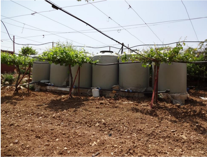
Photographie 5.6 - Stockage d'eau dans des réservoirs en plastique. Cliché : T. NASSER-CEDETE, 2017.
