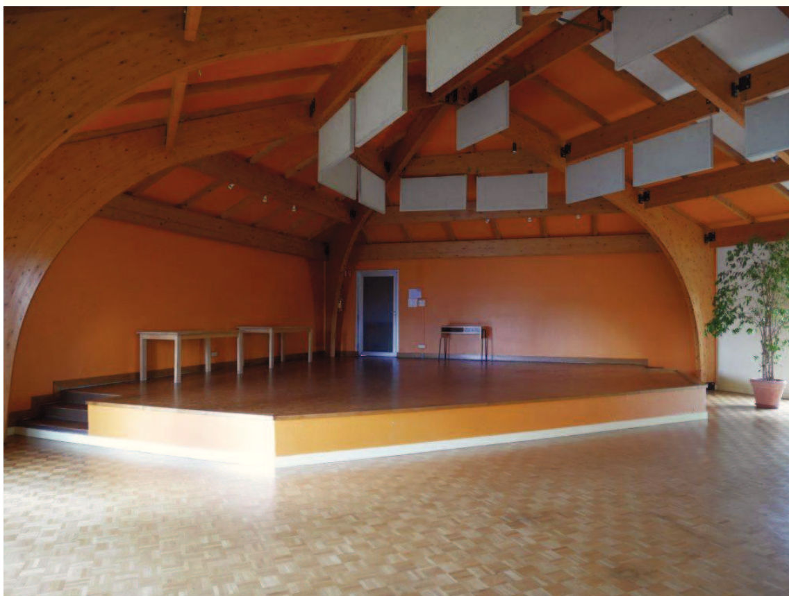
Illustration n° 289 : Maison du temps libre d'Ansac-sur-Vienne. Cl. APMAC Nouvelle-Aquitaine.
