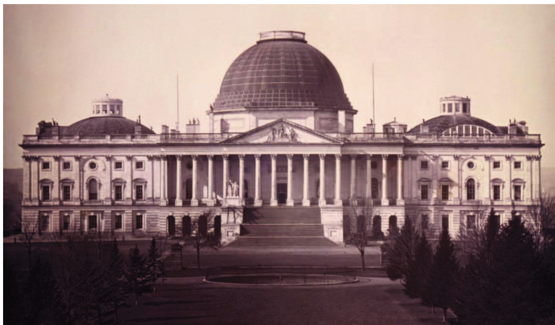
Illustration n° 30 : Capitole de Washington en 1846. Cl. John Plumbe.
