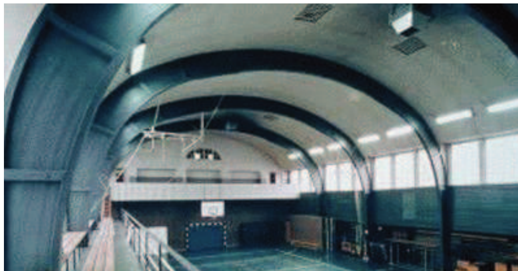
Illustration n° 39 : Gymnase, Celle en Basse-Saxe. Cl. Archives Syndicat du Lamellé Collé.
