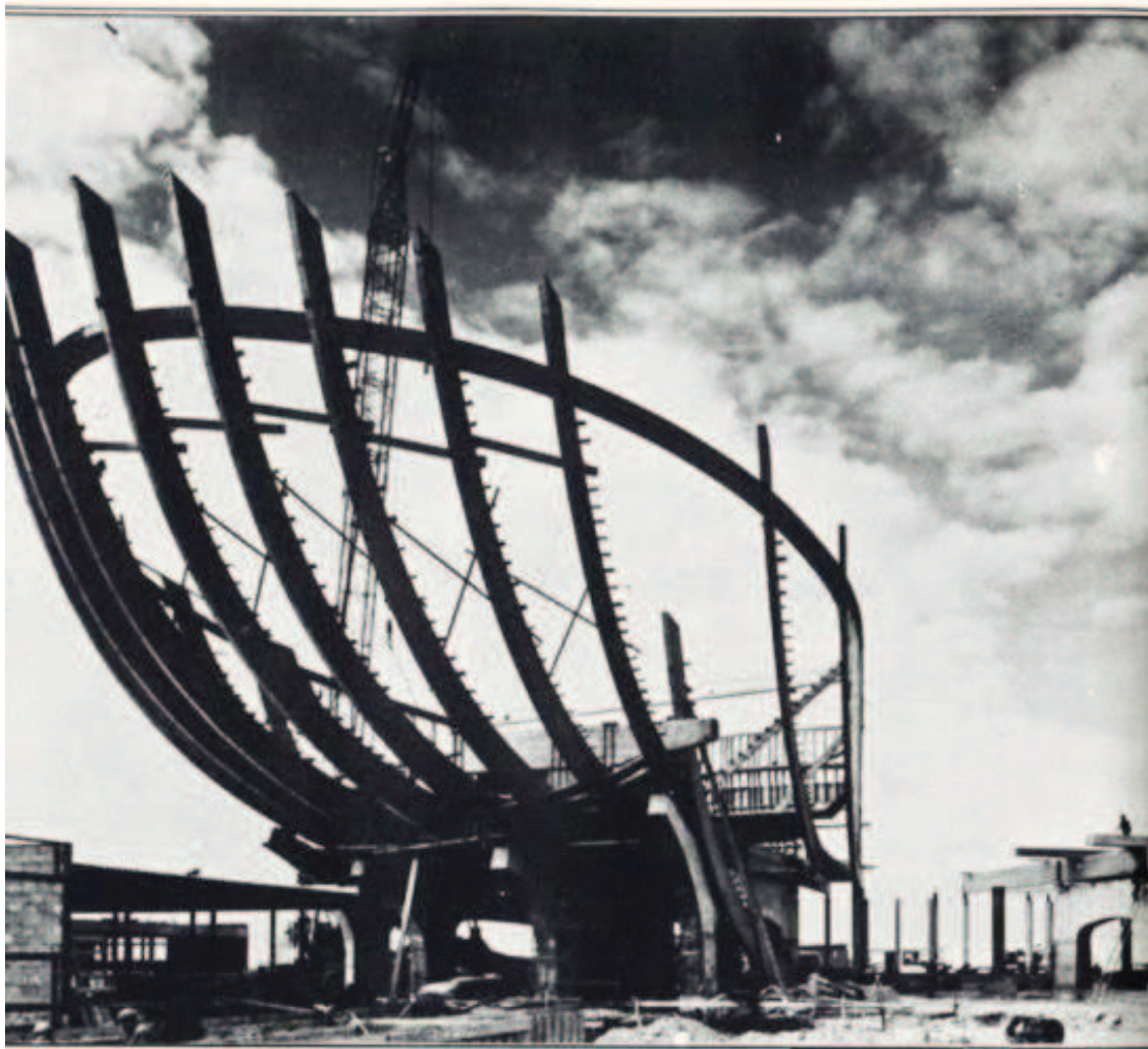
Illustration n° 142 : ossature d'un amphithéâtre de l'université de droit de Reims. « Bois d'aujourd'hui » de 1974.
