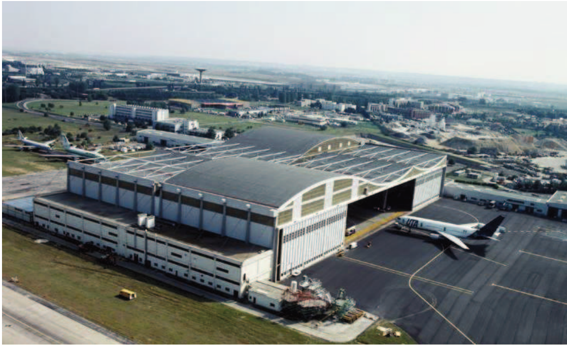
Illustration n° 271 : Hangar de l'Union des Transporteurs Aériens. Photothèque du laboratoire d'Aéroports de Paris.
