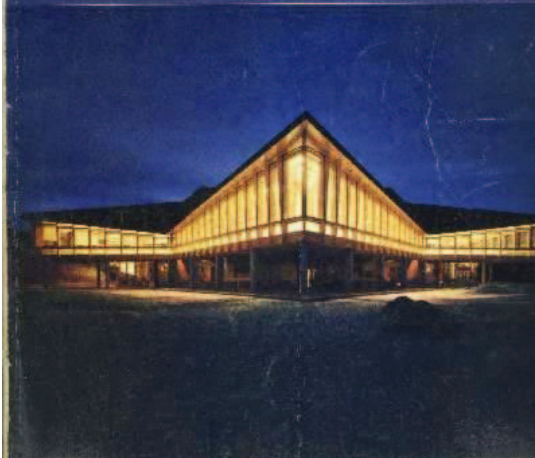
Illustration n° 121 : Restaurant universitaire de Rennes. Couverture du Nouveau Journal de Charpente-Menuiserie-Parquets , 1965.
