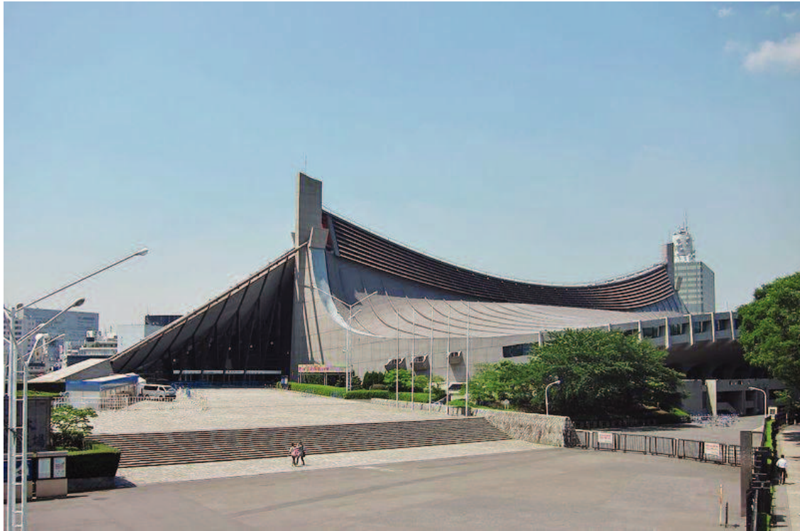
Illustration n° 76 : Gymnase olympique de Tokyo. Cl. Rs1421 ;
