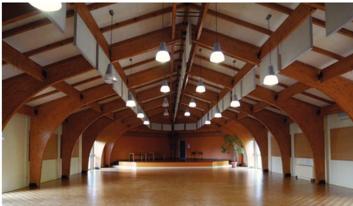
Illustration n° 288 : Maison du temps libre d'Ansac-sur-Vienne. Cl. APMAC Nouvelle-Aquitaine.
