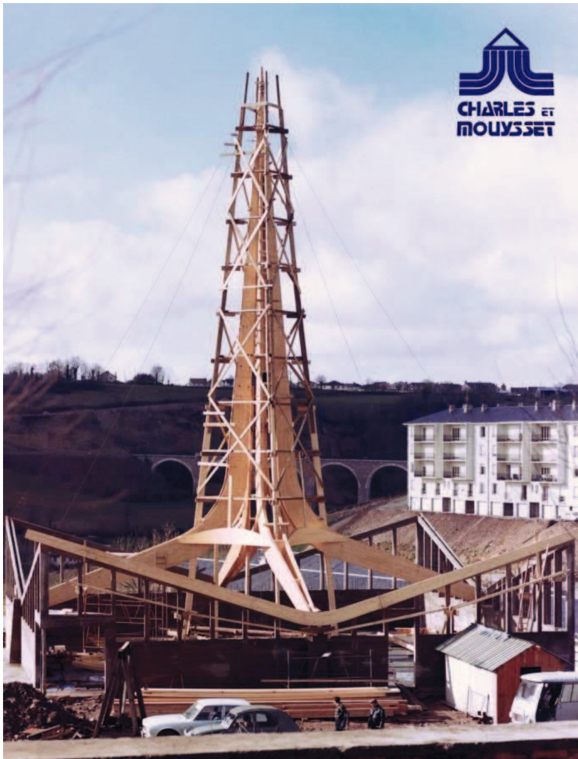
Illustration n° 96 : Eglises de Gougan. Archives entreprise Mouysset.
