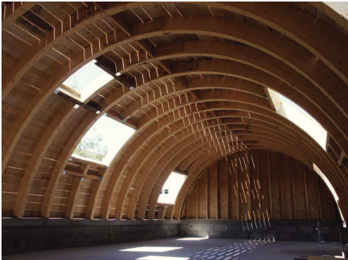
Illustration n° 365 : maison à Nantes d'Eric Dredelot. Archives CNDB.
