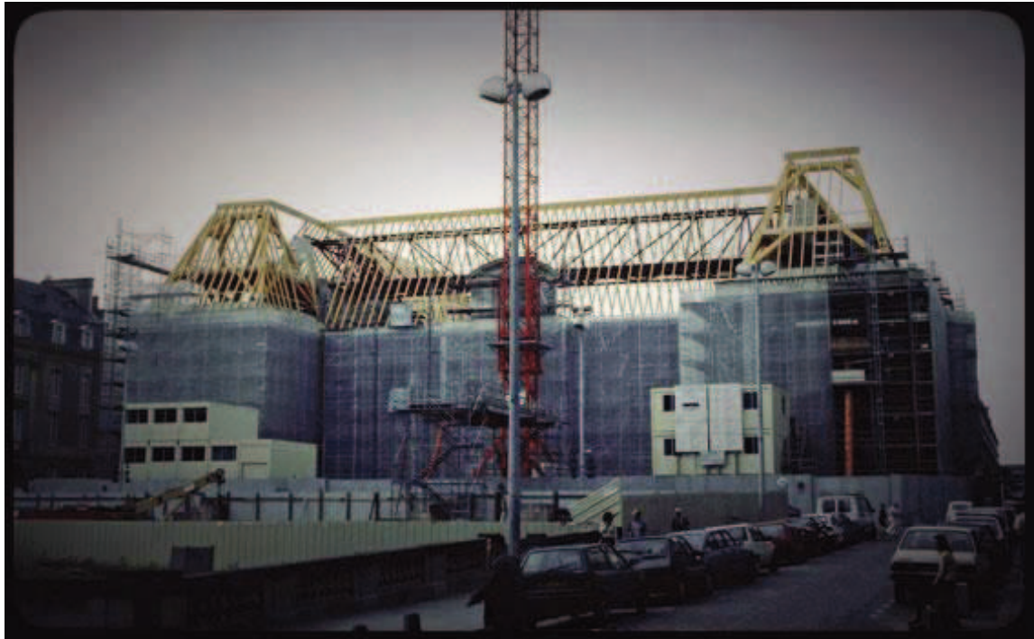
Illustration n° 384 : Restauration du Parlement de Bretagne. Cl. DRAC Bretagne.
