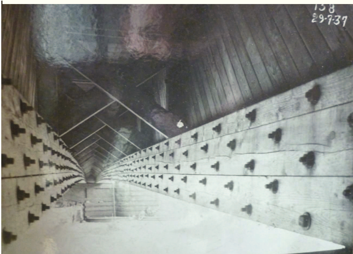
Illustration n° 115 : Pont de l'Alma de l'exposition de 1937. Archives Musée des Compagnons de la rue Mabillon à Paris.
