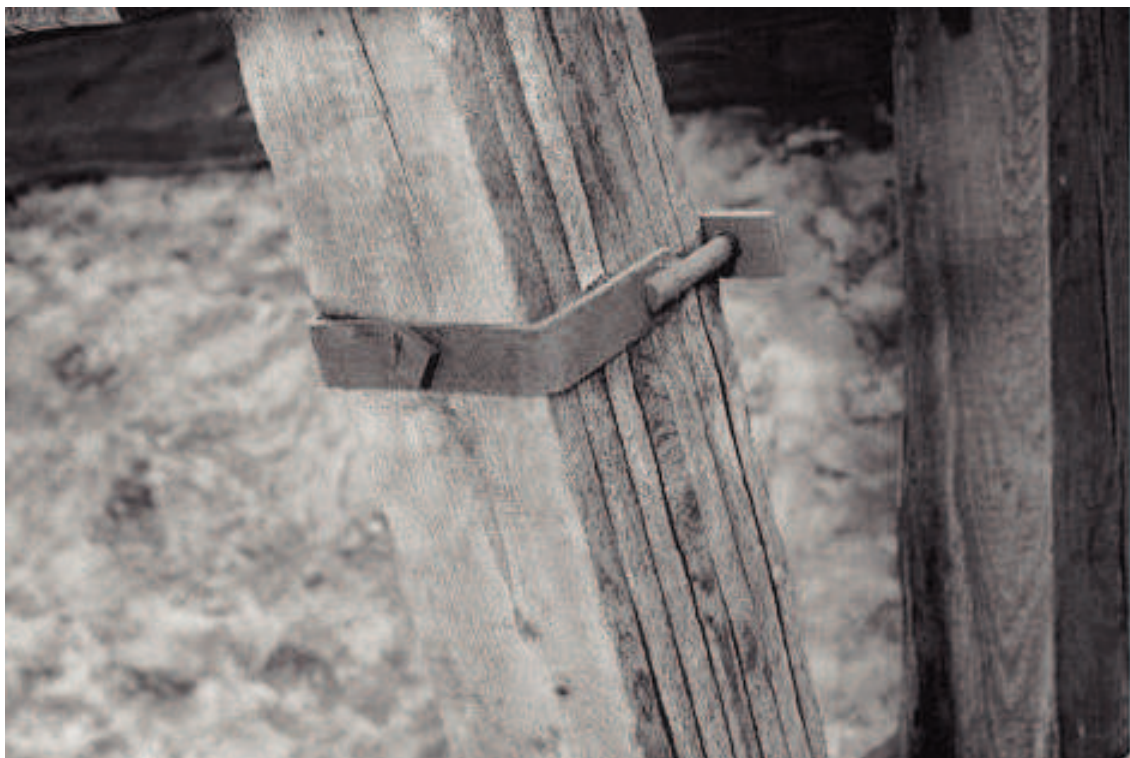
Illustration n° 35 : Détail de la technique du Colonel Emy à l'église de Paray-Vieille-Poste. Phot. Inv. P. Ayrault 02911826X
