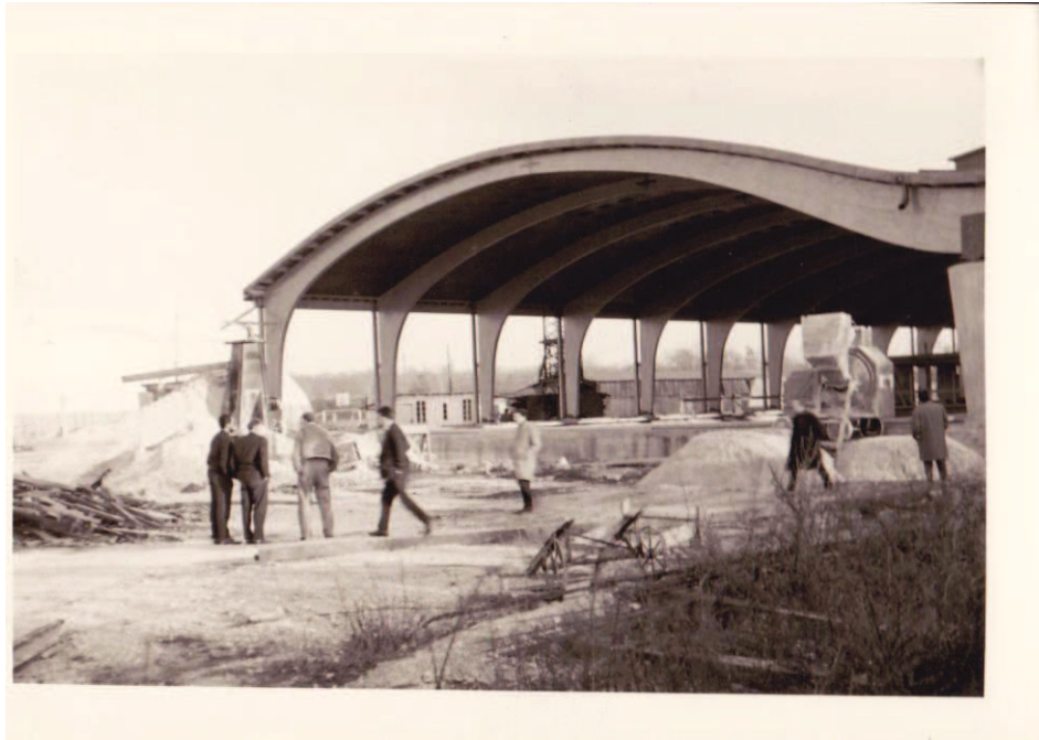
Illustration n° 85 : « Chantier de l'INSEP », photographie de Claude Weisrock, 1962. Cl. Archives entreprise Weisrock.
