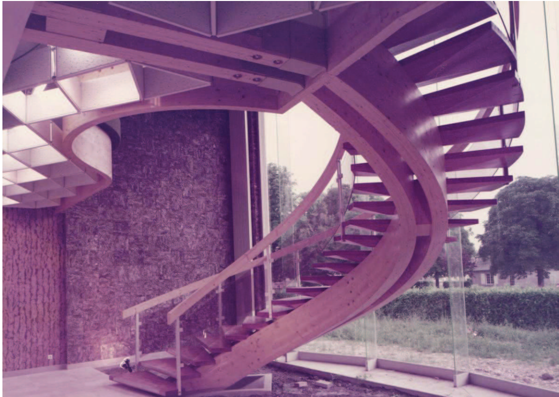
Illustration n° 108 : Escalier de Joué-lès-Tours. Archives du Syndicat du Lamellé Collé.
