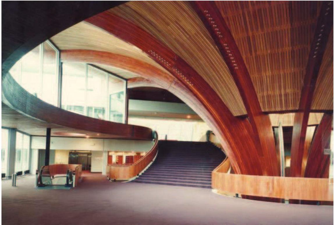
Illustration n° 112 : Grand escalier du Conseil de l'Europe. Archives du Syndicat du Lamellé Collé.
