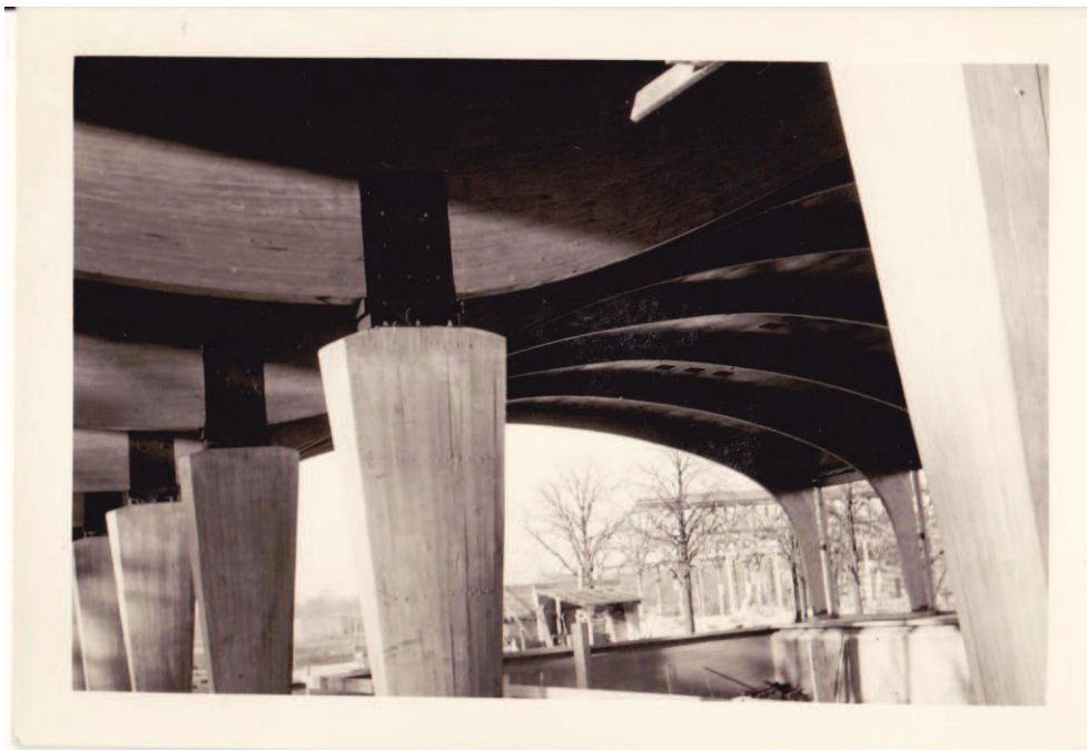
Illustration n° 86 : « Chantier de l'INSEP », photographie de Claude Weisrock, 1962. Cl. Archives entreprise Weisrock.
