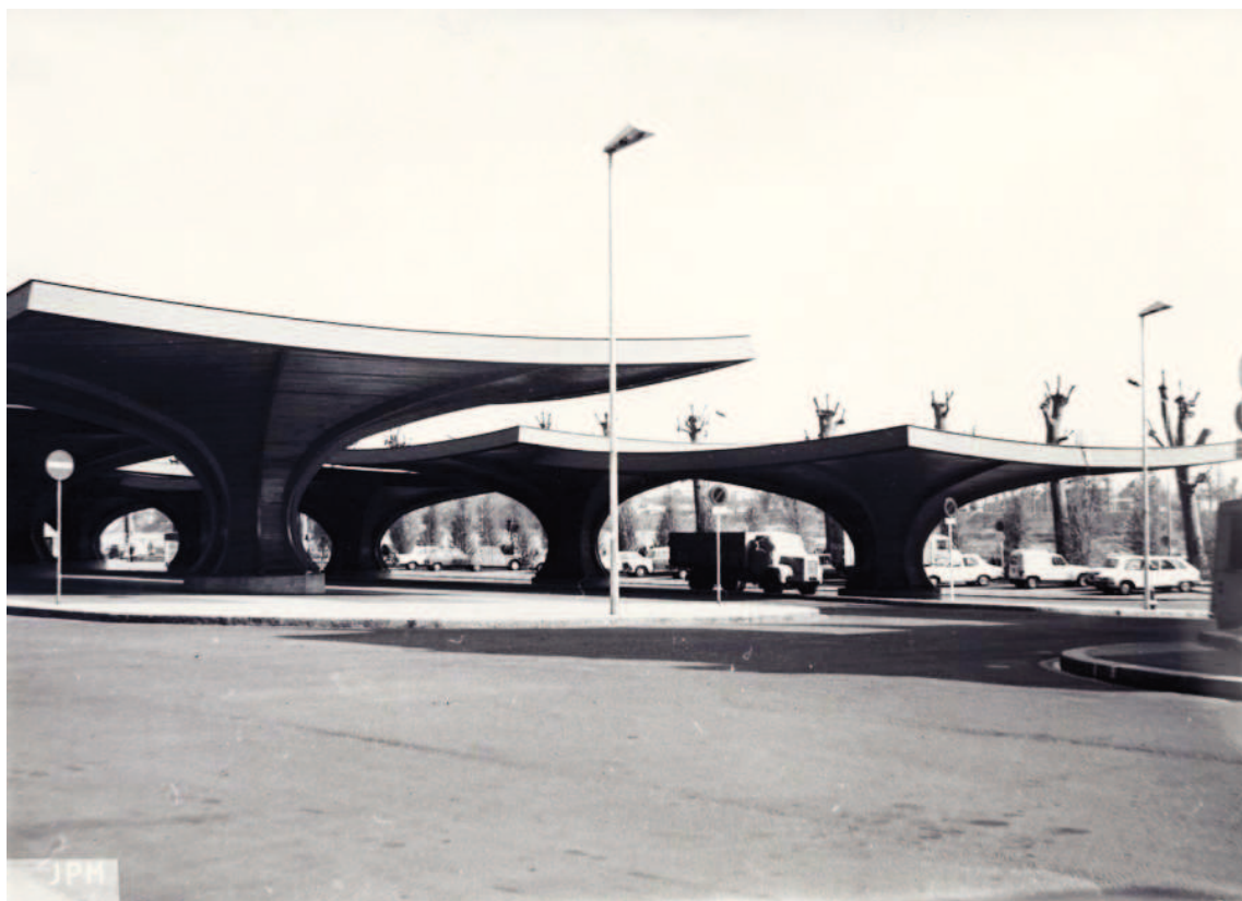
Illustration n° 280 : Halles de la Charpenterie vues depuis la rue des Halles. Vers 1972. J.P. Marmin. Archives municipales d'Orléans, 3Fi1115.
