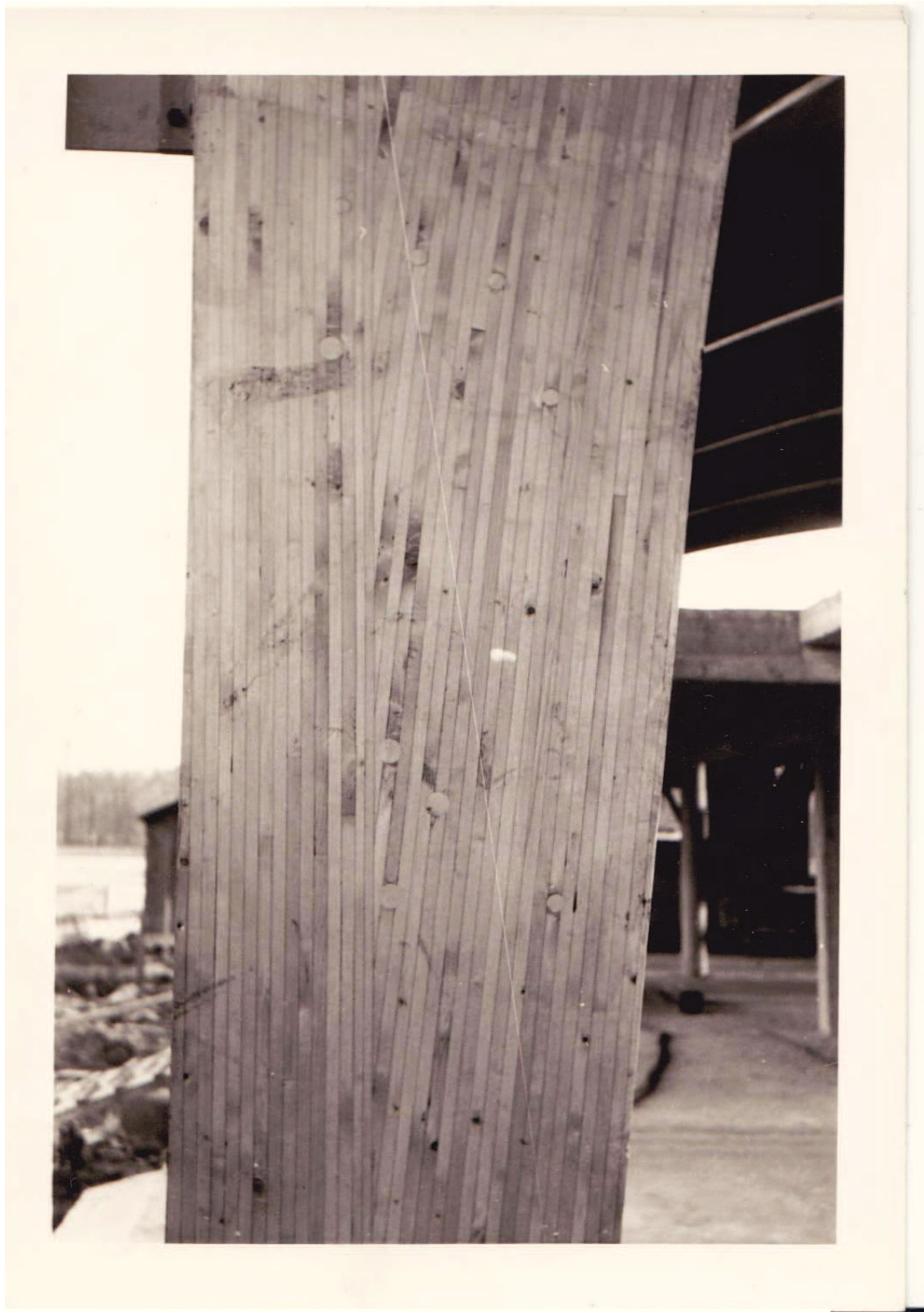
Illustration n° 87 : « Chantier de l'INSEP », photographie de Claude Weisrock, 1962. Cl. Archives entreprise Weisrock.
