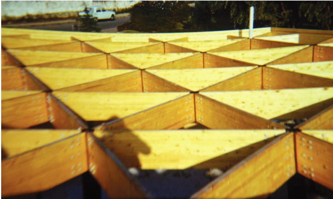
Illustration n° 148 : Charpente lamellée collée du relais paroissial de Saint-Cyr-l'École. Fonds Mouette, Henri (1927-1995). 250 Ifa : Chapitre B. Projets, Objet MOUHE-B-71-3. Relais paroissial Saint-Martin, Saint-Cyr-l'École (Yvelines), 1971-1973.
