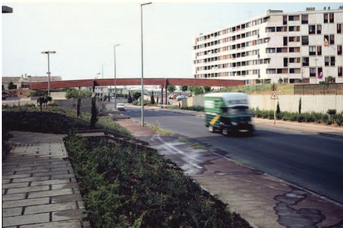
Illustration n° 95 : Exemple d'une passerelle réalisé par Mouysset. Archives entreprise Mouysset.
