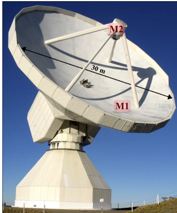
FIGURE 4.1 – Photo du télescope de 30 m de l’IRAM. On y voit le miroir primaire M1 (30 m de diamètre) et le miroir secondaire M2 (2 m de diamètre) qui permettent de renvoyer le rayonnement incident vers l’intérieur de la cabine du télescope. Crédit photo : Florian Ruppin.
