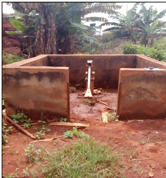
Photo 53 : Forage en panne équipé d'une PMH
