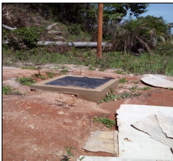
Photo 56 : Forage équipé d'une PE
