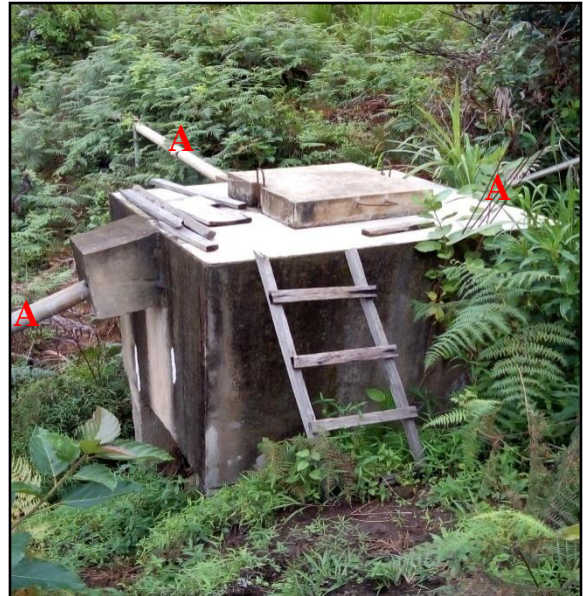
Photo 90 : Bac de décantation des 3 sources
