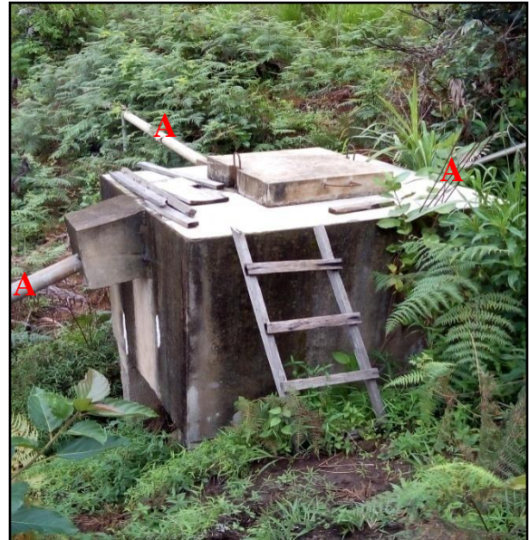
Photo 90 : Bac de décantation des 3 sources
